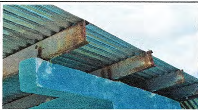
Foto 8: Modulo 2. Mantenimiento a estructura de soporte de metal
