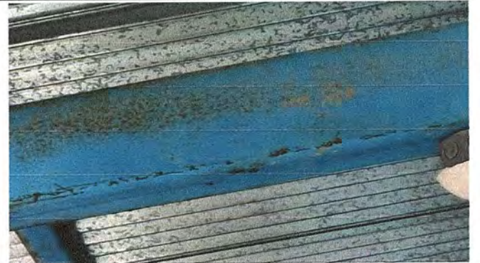
Foto 4: Modulo 1. Mantenimiento de estructura de soporte de metal
