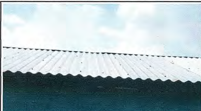
Foto 7: Modulo 2. Sustitución de elementos de fijación (tornillos)
