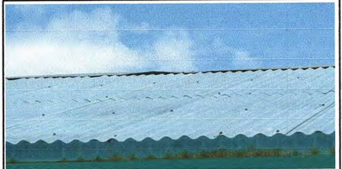
Foto 6: Modulo 2. Sustitución de capote de lámina para lámina troquelada.
