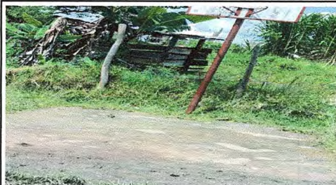
Foto 10: Patio. Reparación de planchas de concreto de patio.
