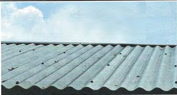
Foto 3: Modulo 1. Sustitución de elementos de fijación (tornillos)
