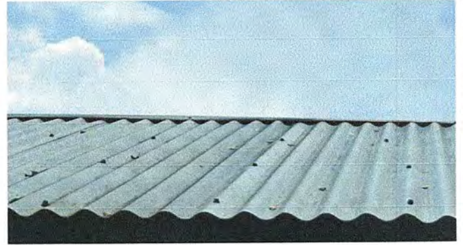
Foto 2: Modulo 1. Sustitución de capote de lámina para lámina troquelada
