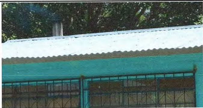
Foto 5: Modulo 2. Sustitución de lámina por lamina troquelada aluzinc calibre 26.
