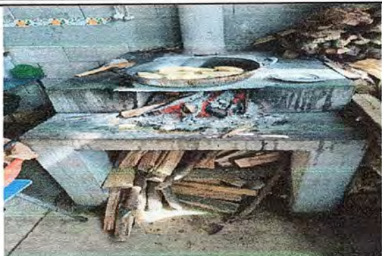
Foto1: Modulo 1. Sustitución de estufa rural (completa) incluye chimenea y plancha de metal
