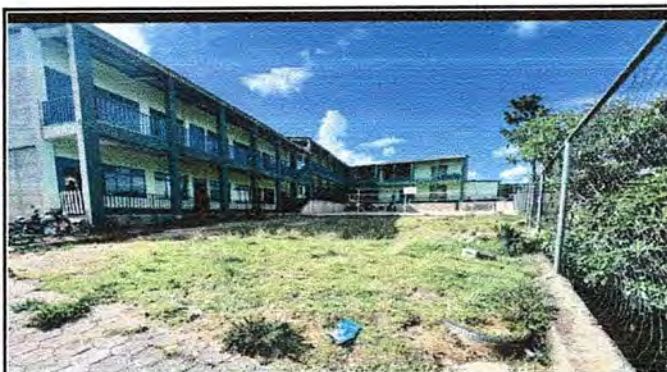
Foto 4: patio. Reparación de planchas de concreto de patio
