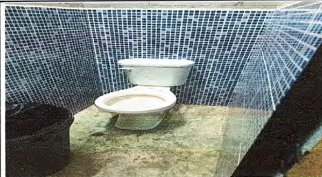
Foto 2: Modulo 2. Sustitución inodoro
