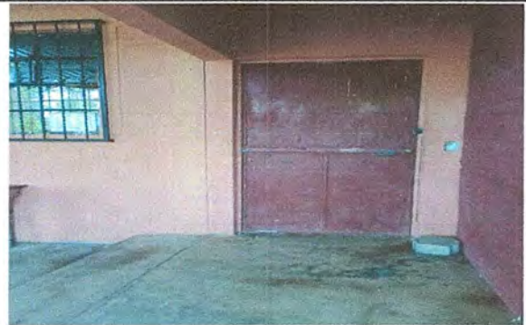
Foto 10: Módulo 2: Sustitución de puerta de metal, por metal.
