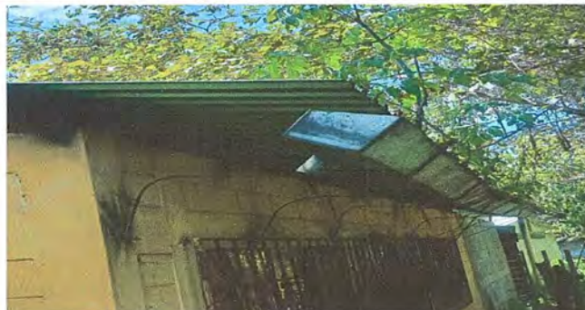
Foto 4: Modulo 1: Sustitución de soporte o pescante de metal para canal
