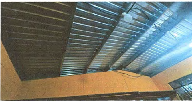
Foto 9: Módulo 2: Suministro e instalación de electromalla.
