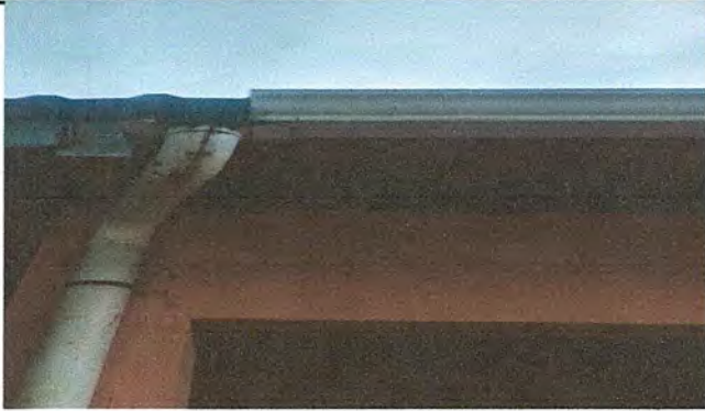
Foto 7: Módulo 2: Sustitución de canal de pvc
