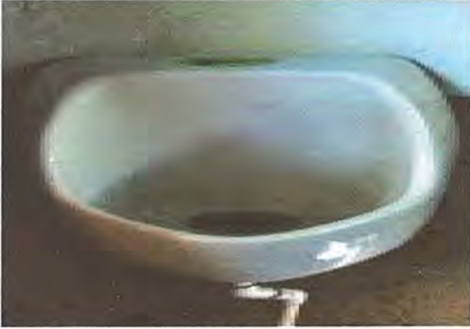
Foto 13: Sanitario: Sustitución de mingitorio
