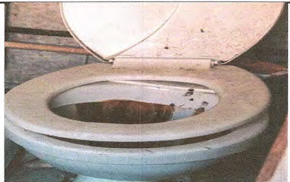
Foto 12: Baño: Sustitución inodoro
