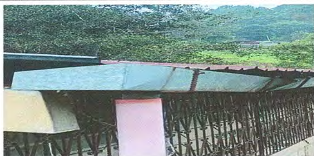
Foto 3: Módulo 1: Sustitución de bajadas de agua pluvial de pvc, por pvc
