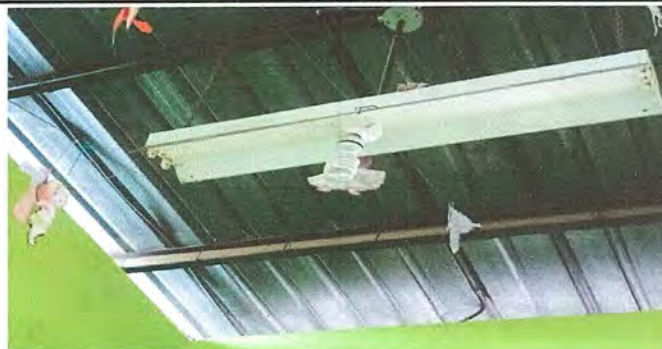
Foto 6: Módulo 1: Sustitución de focos ahorradores
