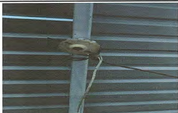
Foto 5: Módulo 1: Sustitución de plafoneras
