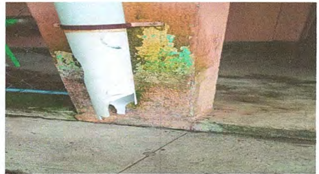
Foto 8: Módulo 2: Sustitución de bajada de agua pluvial de PVC, por tubo PVC 3"
