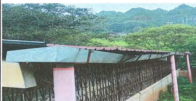
Foto 2: Módulo 1: Sustitución de canales de metal, por metal.
