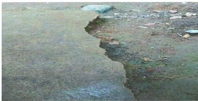
Foto 11: Patio: Reparación de piso de torta de concreto.
