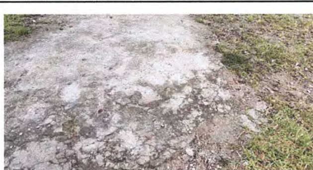
Foto 2: Patio 2. Reparación de plancha de concreto
