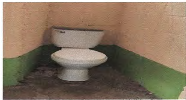
Foto 4: Módulo 2. Suministro en instalacion de azulejo
