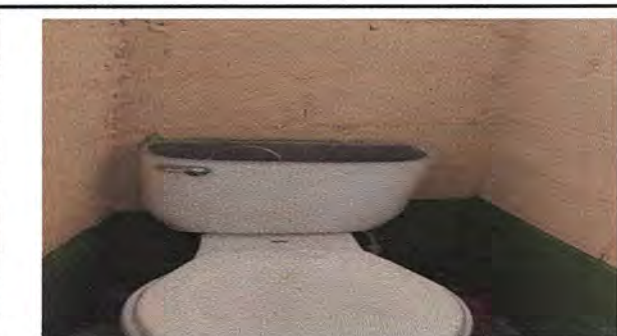
Foto 6: Módulo 2. Sustitución de inodoro
