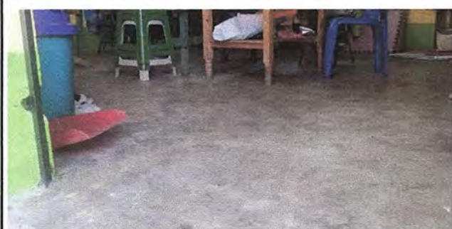
Foto 3: Módulo 1. Sustitucion de piso de torta de concreto por piso cerámico.
