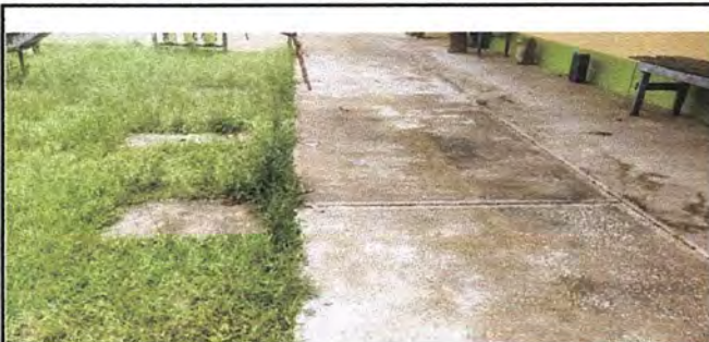
Foto1: Patio 1. Reparación de plancha de concreto
