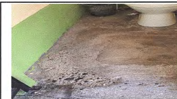
Foto 5: Módulo 2. Sustitucion de piso de torta de concreto por piso antideslizante
