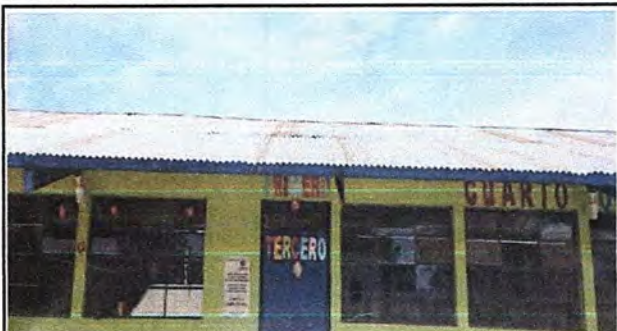
Foto1: Modulo 1. Sustitución de lámina por lamina troquelada aluzinc calibre 26
