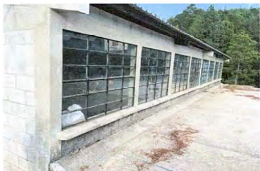
Módulo 1: Suministro, material e instalacion de balcones de hierro en ventanas, pintura en muros exteriores e interiores
