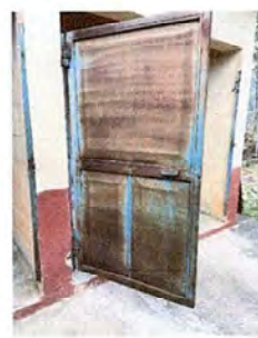
Módulo 4: mantenimiento a estructura de puertas, lijado, cepillado y aplicación de pintura, sustitucion de puerta, pintura en muros exteriores e interiores, sustitucion de tapadera sanitario.
