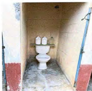
Módulo 4: mantenimiento a estructura de puertas, lijado, cepillado y aplicación de pintura, sustitucion de puerta, pintura en muros exteriores e interiores, sustitucion de tapadera sanitario.
