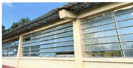
Módulo 2: Suministro, material e instalacion de balcones de hierro en ventanas, pintura en muros exteriores e interiores
