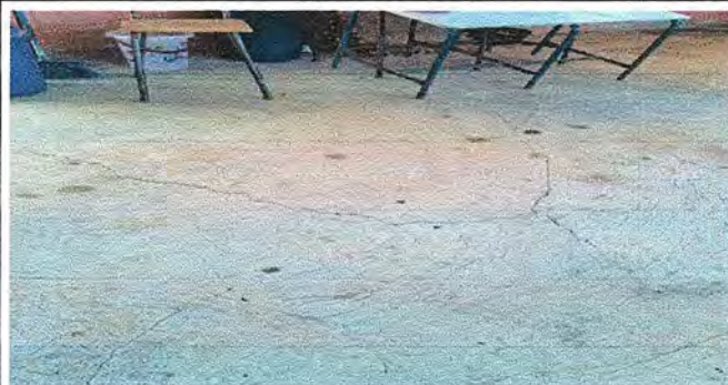
MODULO 2 Foto 4: Sustitución de piso de torta de concreto por piso de granito
