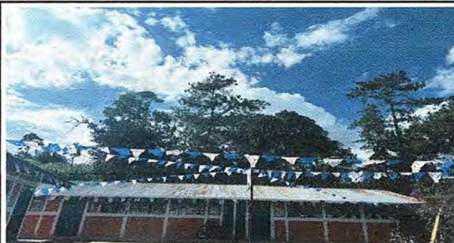
MODULO 2 Foto 2: Sustitución de lamina por lamina aluzinc calibre26
