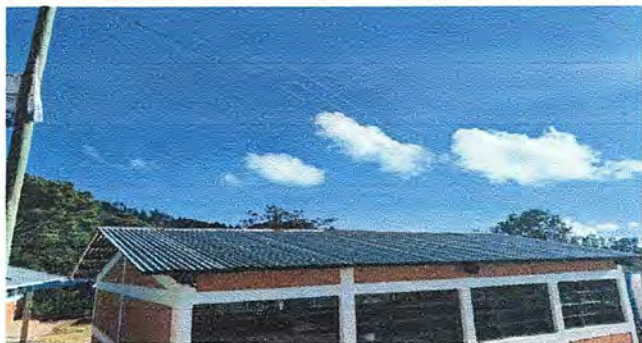
MODULO 1 Foto 1: Sustitución de lamina por lamina aluzinc calibre26
