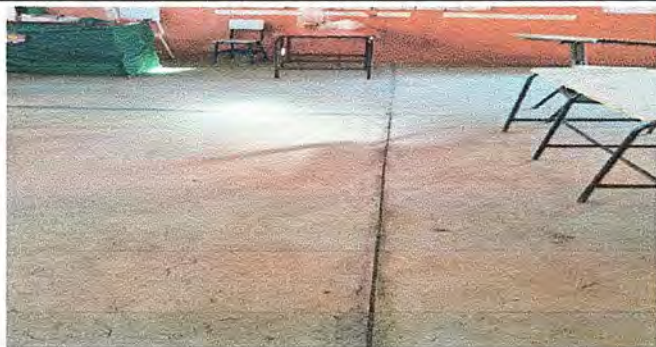
MODULO 1 Foto 3: Sustitución de piso de torta de concreto por piso de granito
