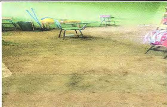
Foto1: Modulo 1. Sustrución de piso de torta de concreto, por piso cerámico
