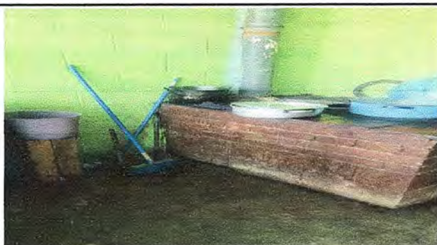
Foto 3: Modulo 2. Sustrución de estufa rural (completa) incluye chimenea y plancha de metal
