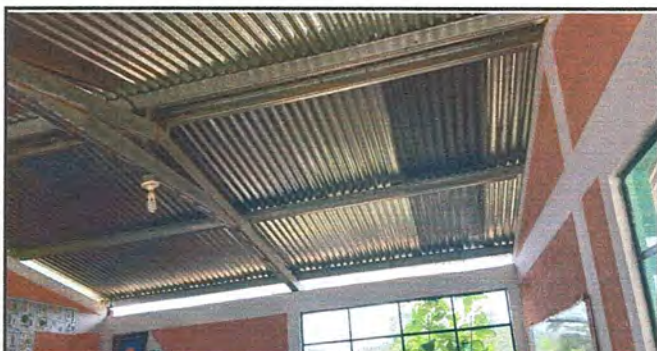
Modulo 3: Sustitución de lamina, por lamina troquelada
