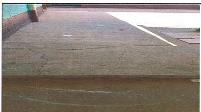
Modulo 2: Sustitución de piso de torta, por piso de granito
