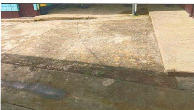
Patio: Cambio de plancha de concreto y sustitución de tubería PVC de aguas pluviales
