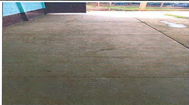
Modulo 1: Sustitución de piso de torta por piso de granito
