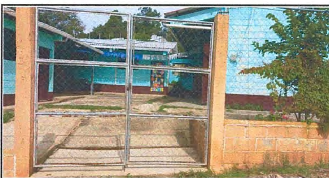
Sustitución de porton, a porton formal de metal
