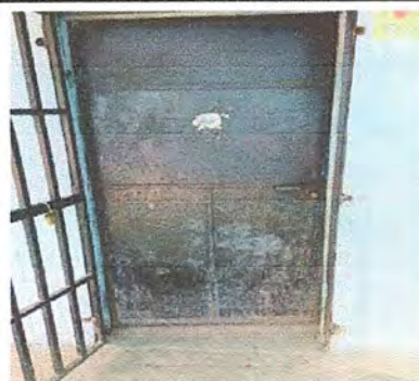
Foto 10: Módulo 2, Sustitución de puerta de metal, por metal
