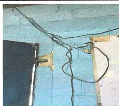
Foto 6. Modulo 2: Sustitución de ducto eléctrico + accesorios
