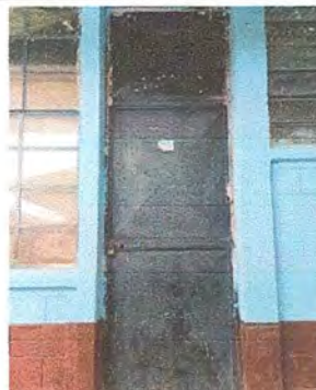
foto 2. Modulo 1: Mantenimiento a puertas de metal
