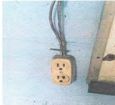
Foto 8: Módulo 2 Sustitución de tomacorrientes dobles
