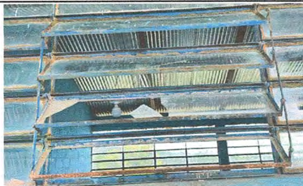
Foto 14: modulo 3:Sustitución de vidrios
