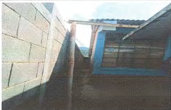
foto 1. Modulo 1: Sustitución de canales de metal, por canales de metal
