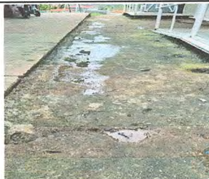
Foto 18: Modulo 7: Sustitución de soporte de metal por canal
