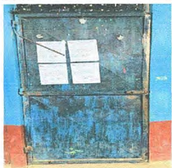
Foto 13: Módulo 5, . Modulo 3: Sustitución de puerta de metal, por metal
