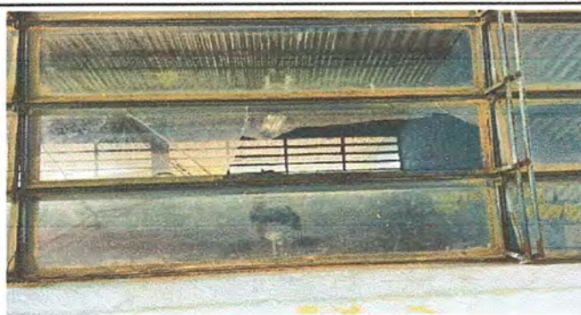
Foto 3. Modulo 1: Sustitución de vidrios
