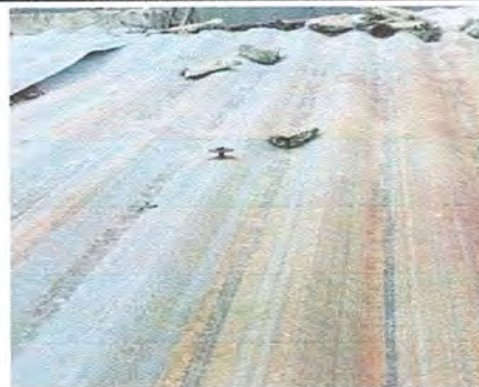
foto 16 Modulo : Sustitución de elementos de fijación (tornillos)
