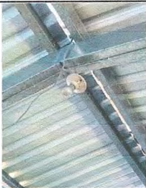
Foto 9: Módulo 2 Sustitución de plafoneras
