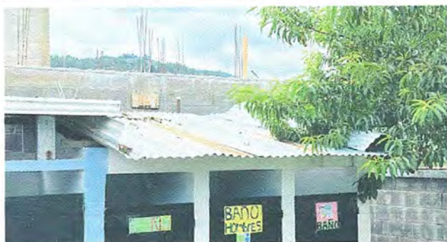
Foto 15: Módulo 6, Sustitución de lamina, por lamina troquelada aluzinc calibre 26
