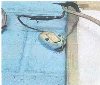
Foto 7: Módulo 2: Sustitución interruptores simples
