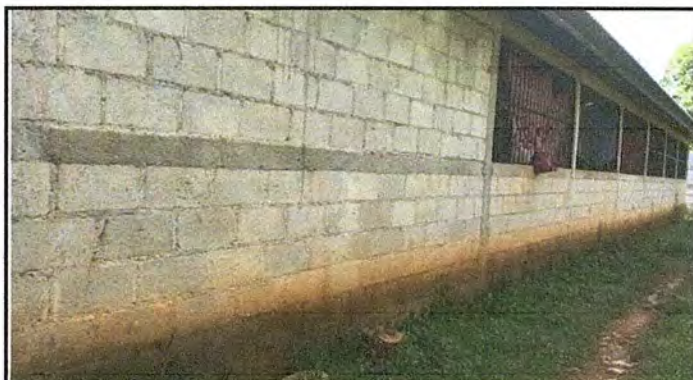
Foto 4. Módulo 1: Repello en muro
