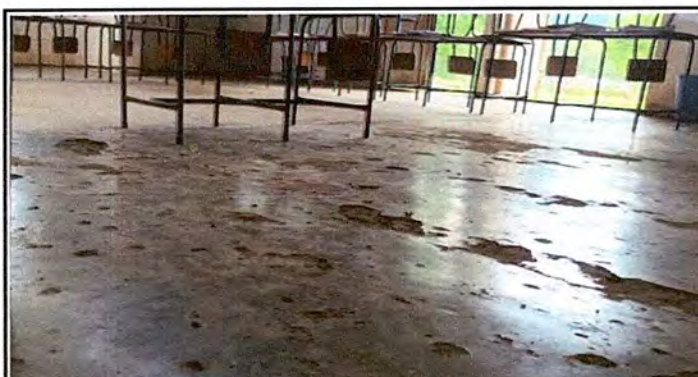
Foto 9. Módulo 2: Reparación de piso de torta de concreto
