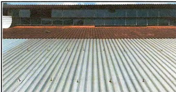
Foto 6. Módulo 2: Sustitución de elementos de fijación (tornillos)
