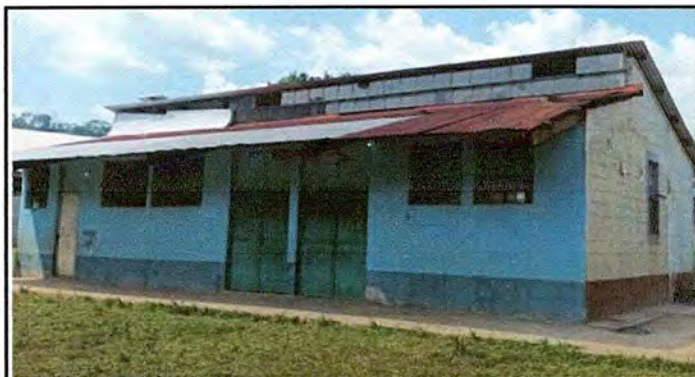
Foto 10. Módulo 2: Pintura en muro exteriores e interiores
