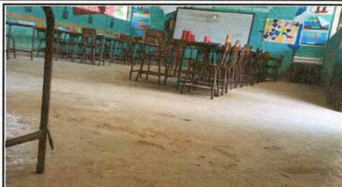
Foto 2. Módulo 1: Sustitución de piso de granito
