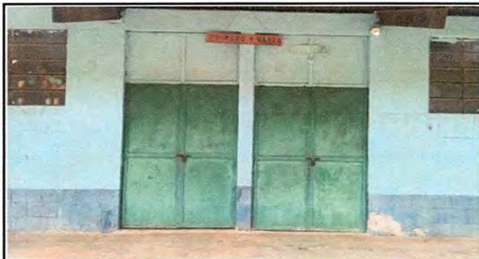
Foto 8. Módulo 2: Sustitución de puerta de metal
