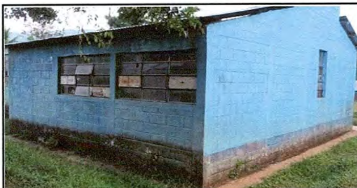
Foto 11. Módulo 2: Repello en muro
