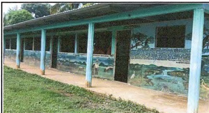
Foto 3. Módulo 1: Pintura en muro exteriores e interiores
