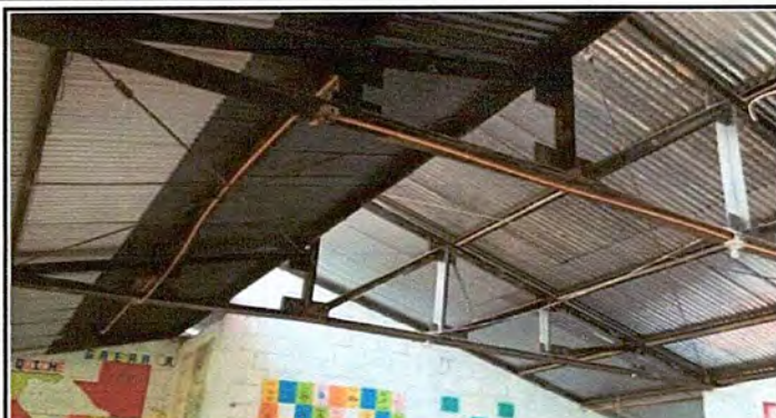
Foto 7. Módulo 2: Mantenimiento a estructura de metal
