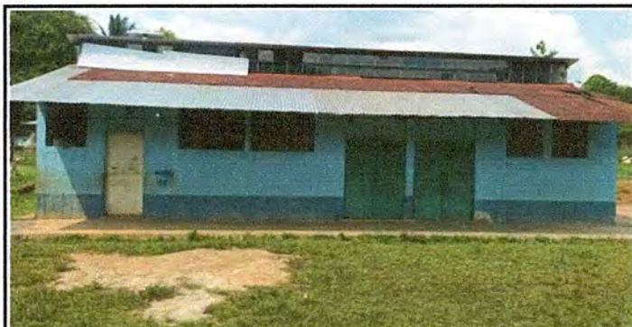
Foto 5. Módulo 2: Sustitución de lámina, para lámina troquelada aluzinc calibre 26
