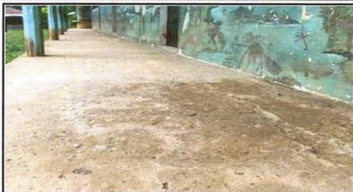
Foto 1. Módulo 1: Reparación de piso de torta de concreto
