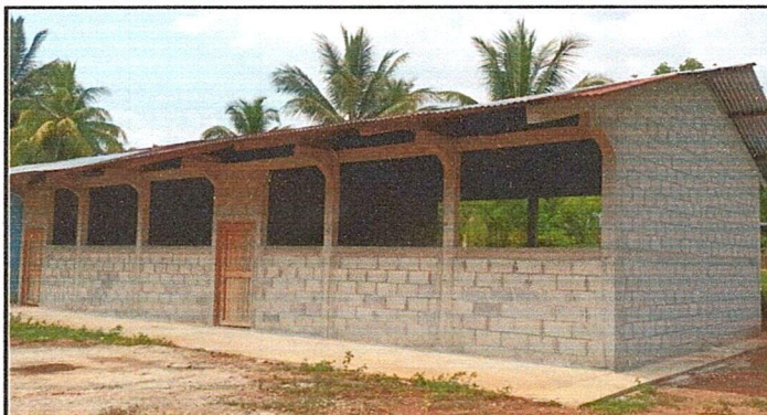
Foto 7. Módulo 4: Pintura en muro exteriores e interiores
