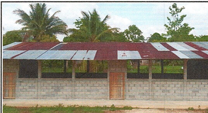
Foto 1. Módulo 4: Sustitución de lámina, por lámina troquelada aluzinc calibre 26
