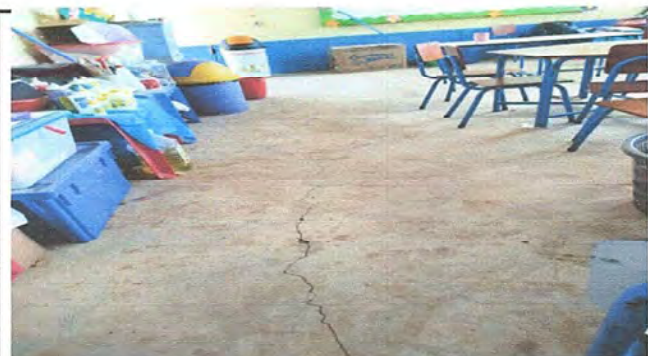
Foto 11: Módulo 3, Sustitución de piso de torta de concreto.
