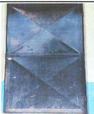
Foto 2: Módulo 1 Mantenimiento a estructura de puerta
