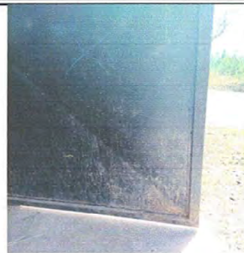
Foto 8: Módulo 2 Mantenimiento de estructura de puerta
