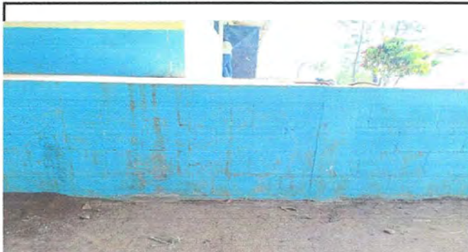
Foto 10: Módulo 3, Pintura muros exteriores
