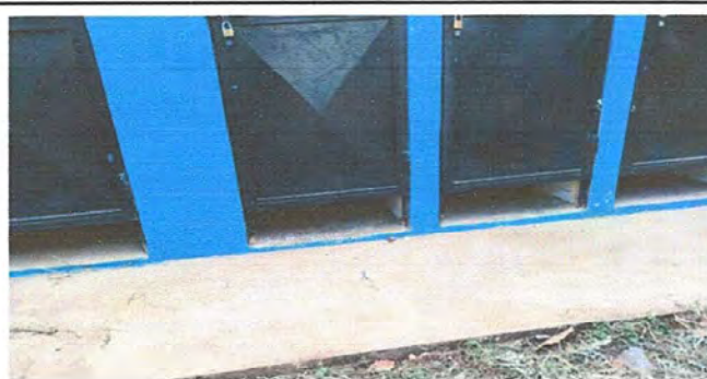
Foto 16: Módulo 4, Mantenimiento a estructura de puerta.
