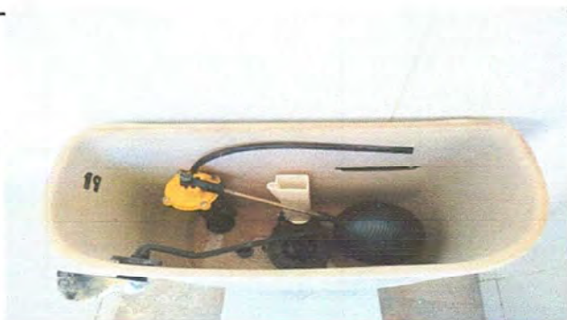
Foto 17: Módulo 4, sustitución de accesorios de inodoro
