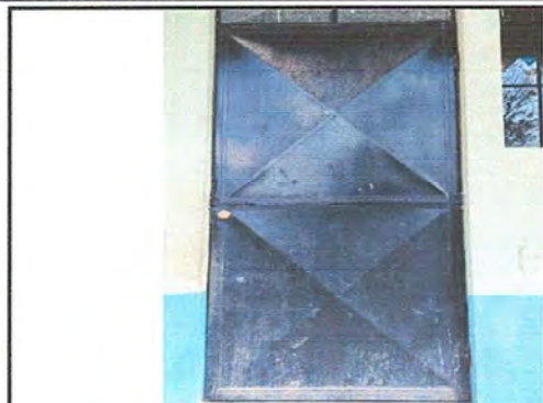
Foto 7: Módulo 2, Mantenimiento de estructura de puerta
