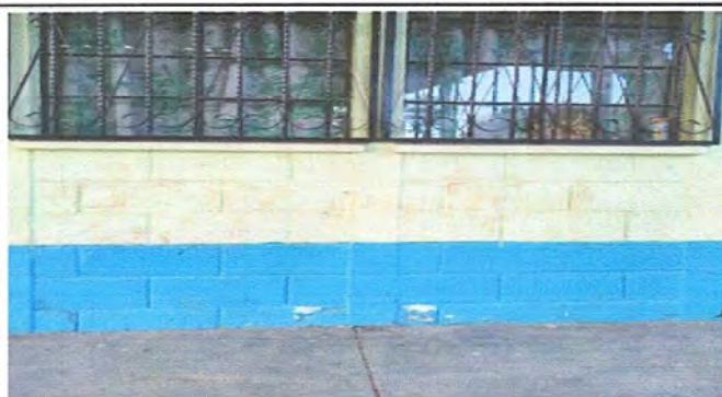
Foto 3: Módulo 1 Pintura en muro interior
