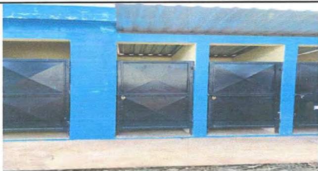
Foto 15: Módulo 4, Mantenimiento a estructura de puerta
