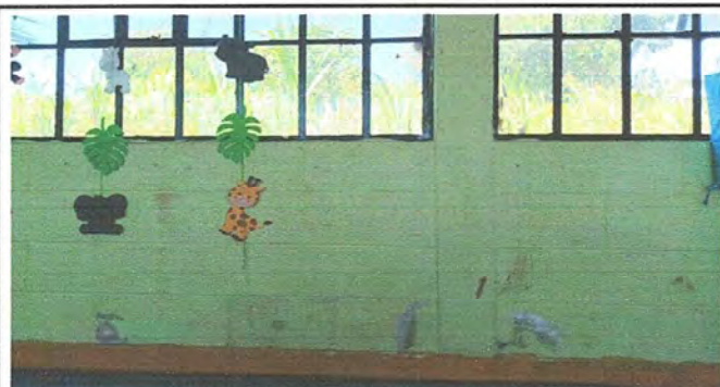
Foto 9: Módulo 3 Pintura en muros de interiores
