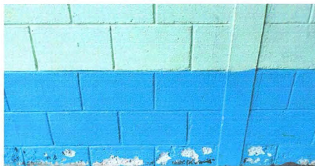
Foto 14 Modulo 3, Pintura muros exteriores
