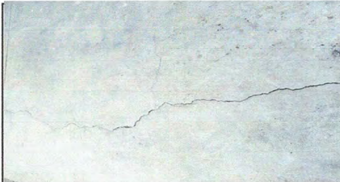
Foto 6: Módulo 2, sustitución de piso de torta de concreto
