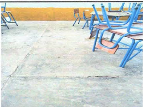
Foto 1: Módulo 1 Sustitución de piso torta de concreto
