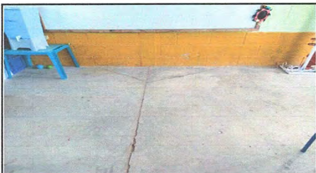
Foto 5: Módulo 2, sustitución de piso de torta de concreto
