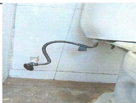
Foto 18: Módulo 4, sustitución accesorio de inodoro
