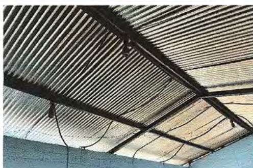
Foto 8. Módulo 2: Sustitución de focos ahorradores.
