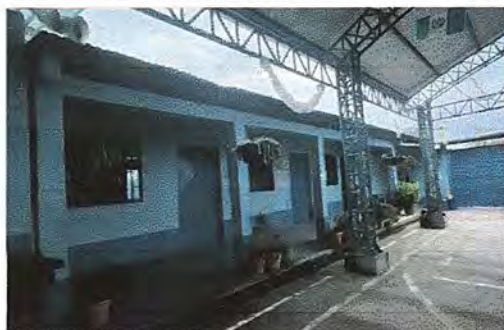
Foto 7. Módulo 2: Sustitución de canales de PVC y bajadas de agua pluvial con tubo PVC.
