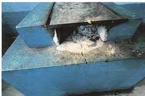
Foto 9. Módulo 2: Sustitución de estufa rural completa.
