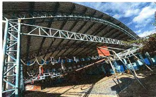
Foto 18. Cancha: Mantenimiento a estructura de soporte de metal de techado.
