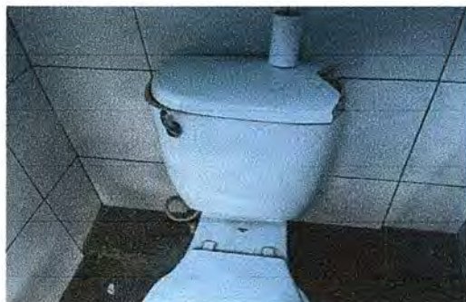
Foto 13. Módulo 3: Sustitución de tanque de inodoro.
