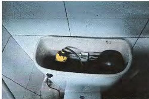
Foto 12. Módulo 3: Sustitución de kits de accesorios de inodoros.
