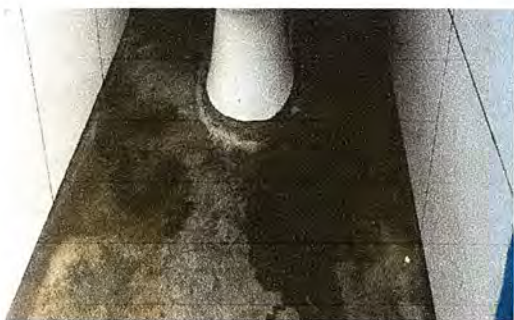
Foto 15. Módulo 3: Sustitución de piso de cemento líquido por piso cerámico.
