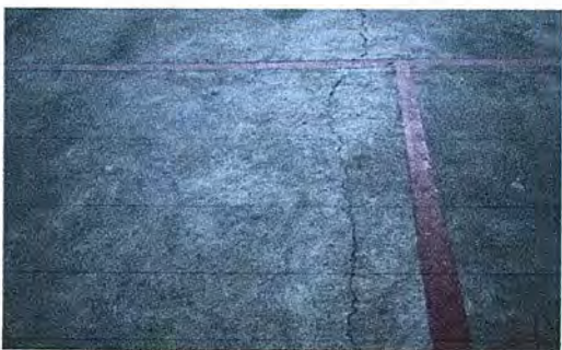
Foto 17. Cancha: Reparación de plancha de concreto de patio.
