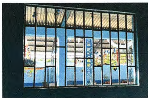
Foto 4. Módulo 2: Suministro e instalación de ventanas de PVC.
