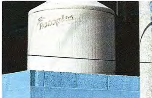
Foto 14. Módulo 3: Sustitución de depósito de agua de 1100 lt.
