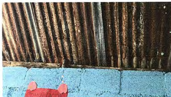
Foto 2. Módulo 2: Sustitución de estructura de soporte de madera por metal.
