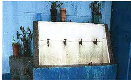
Foto 16. Módulo 3: Sustitución de azulejos en lavamanos.
