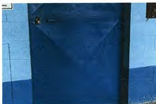
Foto 3. Módulo 2: Mantenimiento a estructura de puerta (lijado, cambio de tubo, cepillado, sujeciones, aplicación de pintura), incluye corte.
