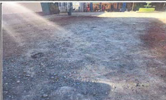
Foto 7: PATIO: Reparación de piso de torta de concreto
