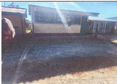
Foto 3: MODULO 3: Pintura en muros exteriores e inferiores
