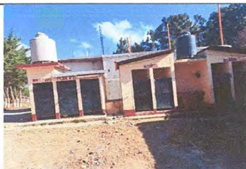
Foto 5: MODULO 4: Sustitución de depósito de agua 2,500 lt
