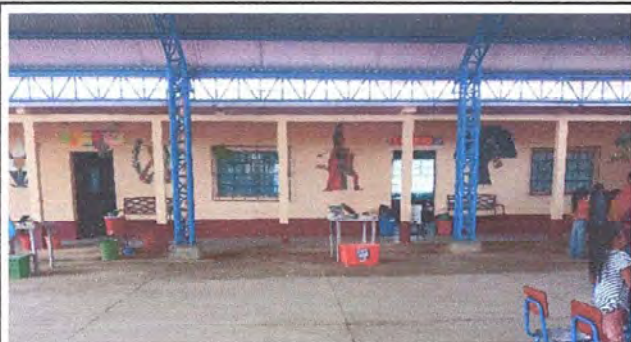
Foto1: MODULO 1: Pintura en muros exteriores e inferiores.
