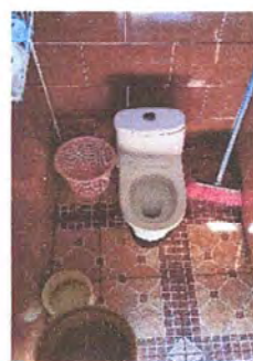
Foto 4: MODULO 4: Sustitución de inodoro
