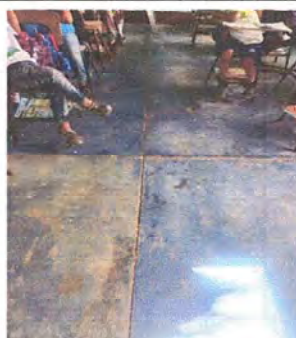
Foto 2: MODULO 3: Sustitución de torta de concreto por piso cerámico
