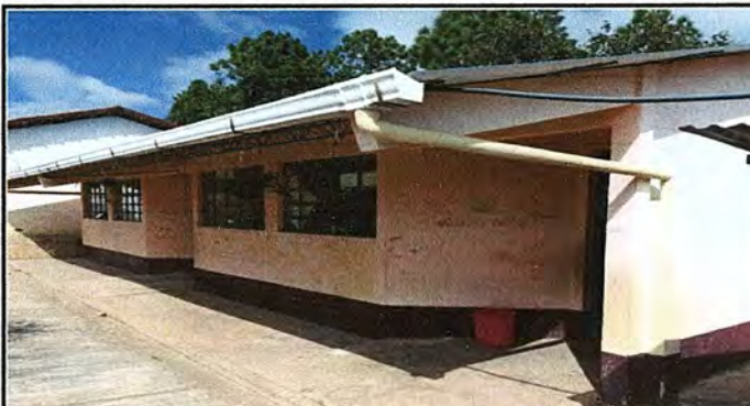
Foto 2: MODULO 4: Suministro e instalación de balcón de metal
