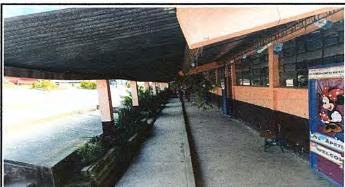
Foto 3:PINTURA GENERAL: Pintura de muros exteriores.
