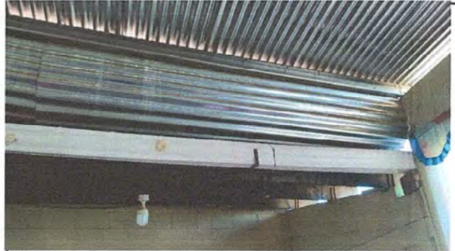
Foto 8: Módulo 5. Sustrucción de bajada de agua pluvial, PVC 3"
