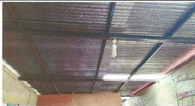
Foto 3: Módulo 1. Módulo 1. Sustitución de lámina troquelada.
