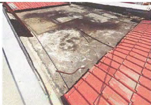
Foto 5: Módulo 2. Impermeabilización de terraza.
