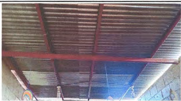
Foto1: Módulo 1. Sustitución de lámina troquelada.
