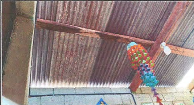
Foto 4: Módulo 1. Sustitución de lámina troquelada y soporte de madera por metal.
