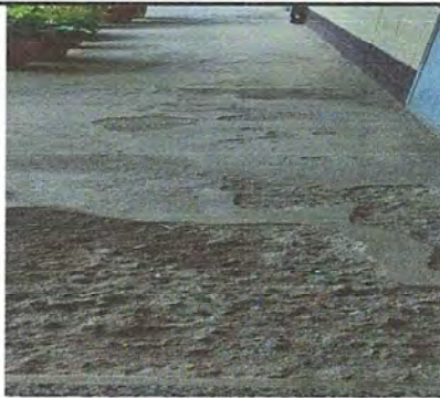
Foto 7. Módulo 4 Sustrucción de piso de torta de concreto por piso de granito
