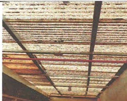
Foto 2: Módulo 1. Sustitución de lámina troquelada.
