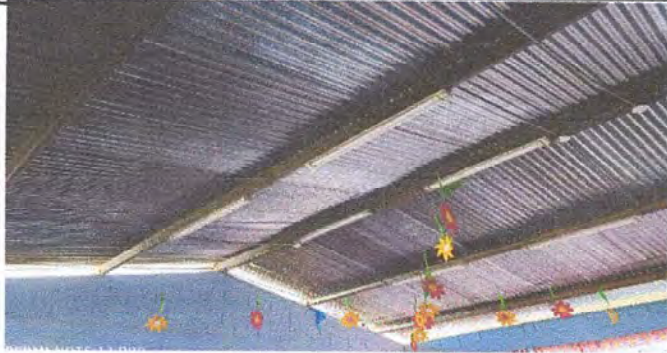
Foto1: Modulo 1: Sustitución de lámina por lámina troquele aluzinc calibre 26
