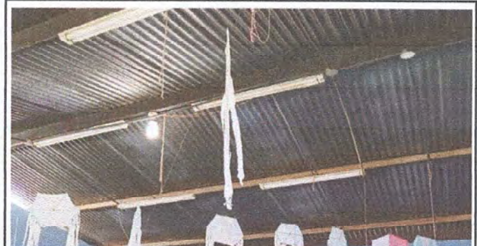
Foto 4: MODULO 1: SUSTITUCIÓN DE LAMPARAS, SUSTITUCIÓN DE CABLEADO ELECTRICO Y SUSTITUCIÓN DE DUCTO ELECTRICO.
