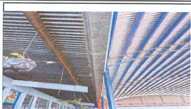
Foto 2: MODULO 1: Mantenimiento de estructura portante
