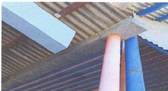
Foto 3: MODULO 1: SUSTITUCIÓN DE CANAL Y SUSTITUCIÓN DE BAJADAS DE AGUA PLUVIAL
