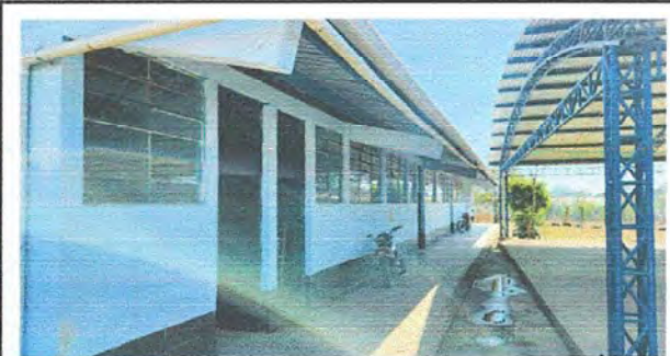
Foto 4: Módulo 2, suministro e instalación de balcón de hierro
