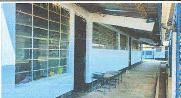
Foto 3: Módulo 1, suministro e instalación de balcón de hierro
