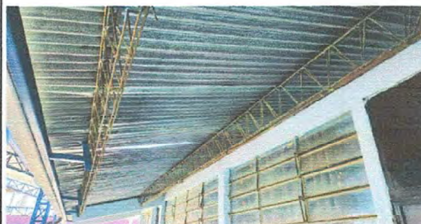
Foto 2: Módulo 1: Mantenimiento de estructura de metal.
