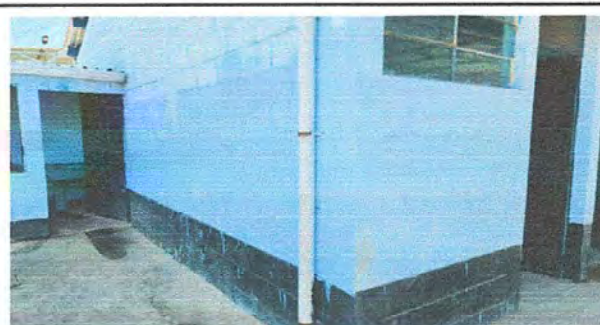
Foto 5: Módulo 1 y 2: Pintura en muros exterior.
