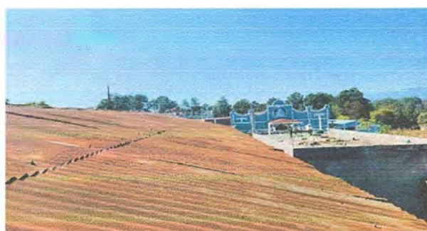
Foto 1: Módulo 1: Sustitución de lámina por lámina troquelada
