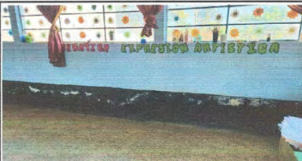
Foto 6: Módulo 1 y 2: Pintura en muros interior.
