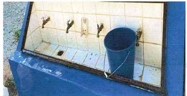
Foto 10: MODULO 2: Sustitución de grifos
