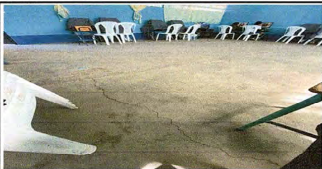
Foto 13: MODULO 4: Sustitución de piso de torta de concreto (aula y dirección)
