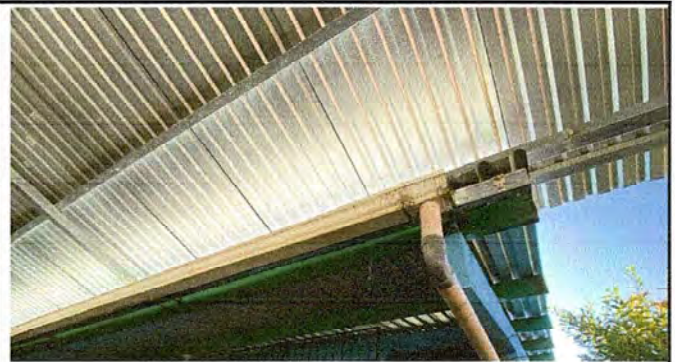
Foto 8: MODULO 2: Sustitución de canal de pvc
