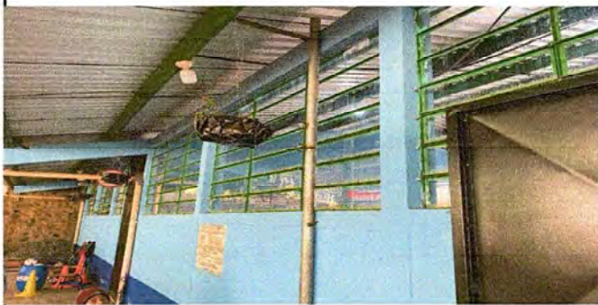
Foto 6: MODULO 2: Suministro e instalación de balcon de hierro en ventana
