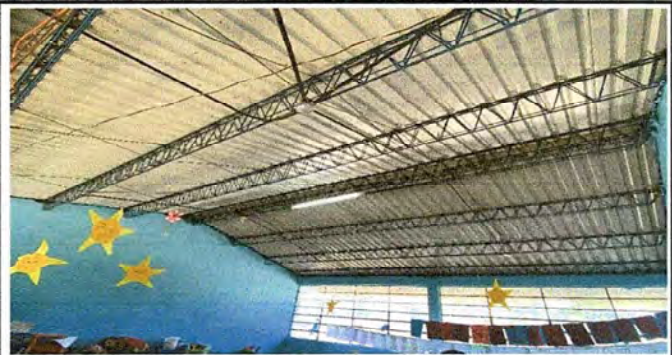
Foto2: MODULO 1. Instalación de unidades de Luz, (incluye interruptor, ducto y cable electrico).
