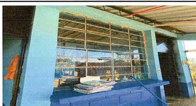
Foto 14: MODULO 4: suministro e instalación de balcon de hierro en ventana (dirección)
