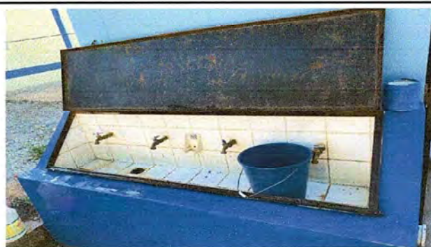
Foto 11: MODULO 2: sustitución de tapadera(lavamano).
