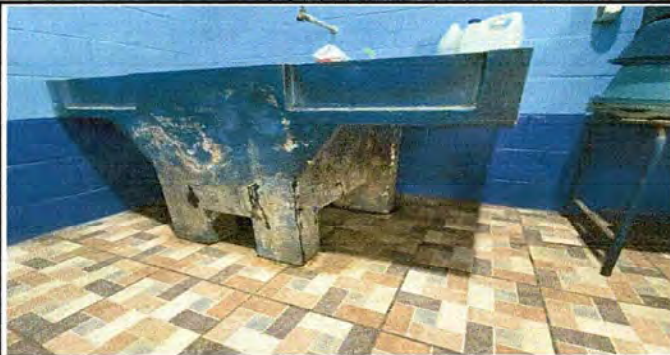
Foto1: MODULO 1. Sustitución de pilas de cemento de dos lavaderos.
