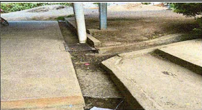
Foto 3: MODULO 1: Reparación de cuneta de concreto.
