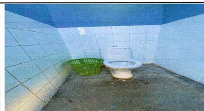
Foto 15: MODULO 4: sustitución de accesorios (inodoro, contrallave, tubo de abasto y taque).
