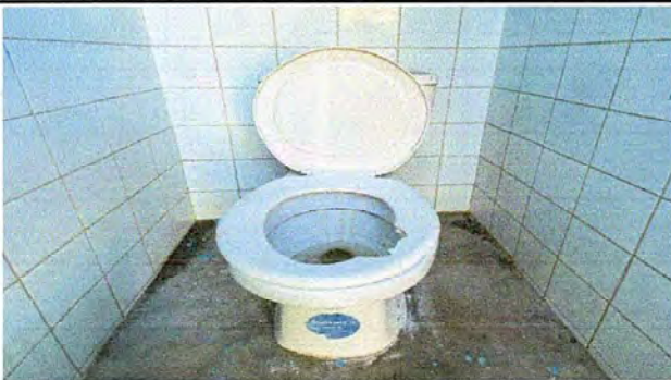
Foto 9: MODULO 2: Sustitución de accesorio (inodoro, contrallave, tubo de abasto y tanque).
