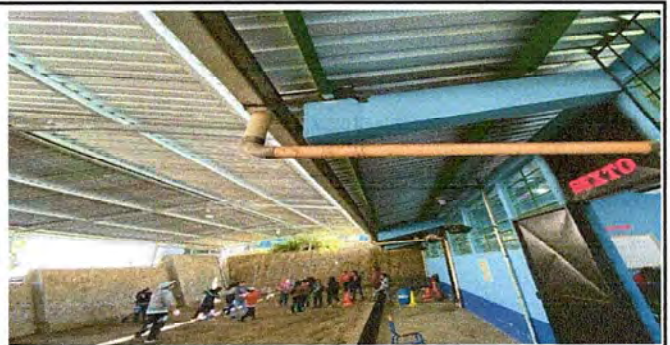
Foto 12: MODULO 3: Instalación de unidades de luz, (incluye interruptor, ductoy cable electrico).
