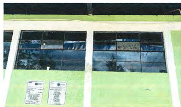
Foto 4: Modulo 1. Mantenimiento a estructura de metal en ventanas
