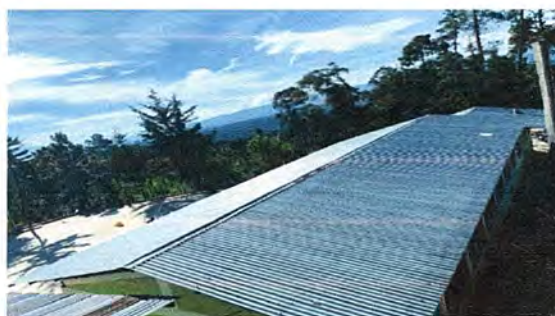
Foto 6: Modulo 2 sustitución de lamina troquelada aluzinc calibre 26
