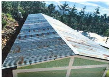
Foto1: Modulo 1 sustitución de lamina troquelada aluzinc calibre 26
