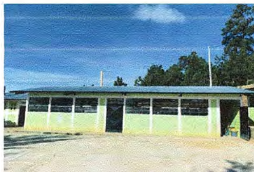
Foto 8: Modulo 2 mantenimiento a estructuras de puertas (lijado, cambio de tubo, cepillado, sujeciones, aplicación de pintura)
