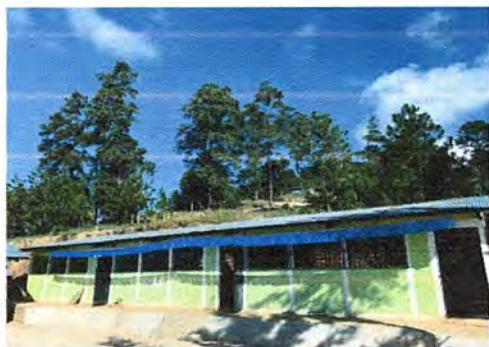
Foto 3: Modulo 1 mantenimiento a estructuras de puertas (lijado, cambio de tubo, cepillado, sujeciones, aplicación de pintura)
