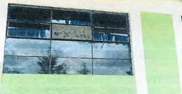
Foto 9: Modulo 2. Mantenimiento a estructura de metal en ventanas
