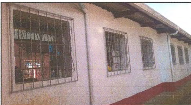
FOTO 4. MODULO 1: SUSTITUCIÓN DE ESTRUCTURA DE METAL DE VENTANA POR PVC EN LA PARTE DE ATRÁS DE LAS AULAS.
