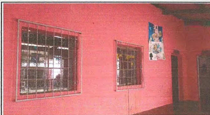
FOTO 2. MODULO 1: SUSTITUCIÓN DE ESTRUCTURA DE METAL DE VENTANA POR PVC EN EL CORREDOR.
