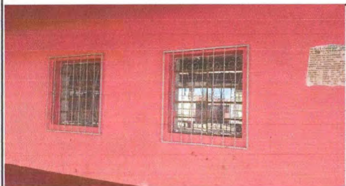
FOTO 3. MODULO 1: SUSTITUCIÓN DE ESTRUCTURA DE METAL DE VENTANA POR PVC EN EL CORREDOR.
