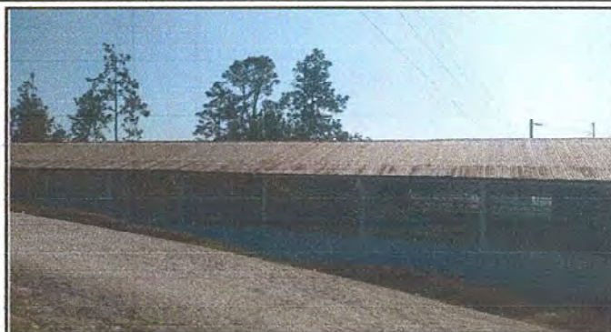
FOTO 8. MODULO 3: SUSTITUCION DE LAMINA, POR LAMINA TROQUELADA CALIBRE 26.
