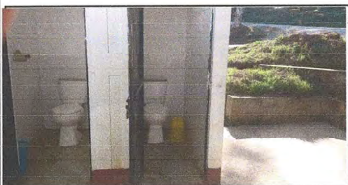
FOTO 11. MODULO 4. SUSTITUCION DE 2 INODORO GRANDE.
