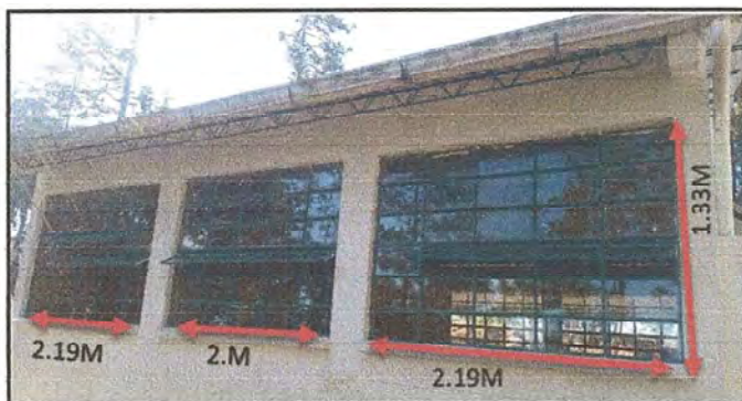
FOTO 12. MODULO 4: SUSTITUCIÓN DE ESTRUCTURA DE METAL DE VENTANA POR PVC Y SUMINISTRO E INSTALACION DE BALCON DE METAL
