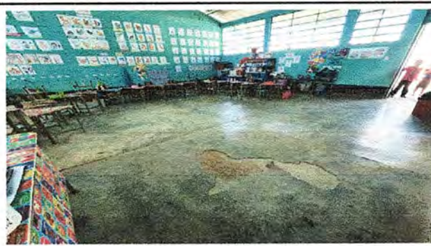
Foto 8: MODULO 3 SUSTITUCION DE PISO DE TORTA DE CONCRETO POR PISO GRANITO
