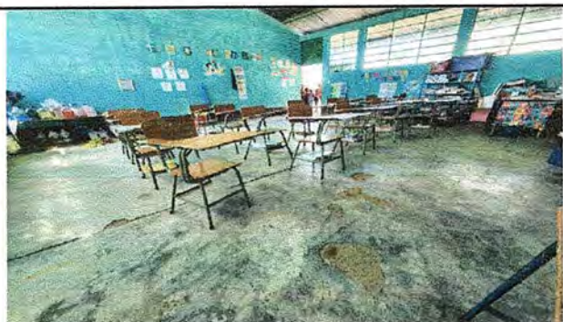
Foto 7: MODULO 3 SUSTITUCION DE PISO DE TORTA DE CONCRETO POR PISO GRANITO
