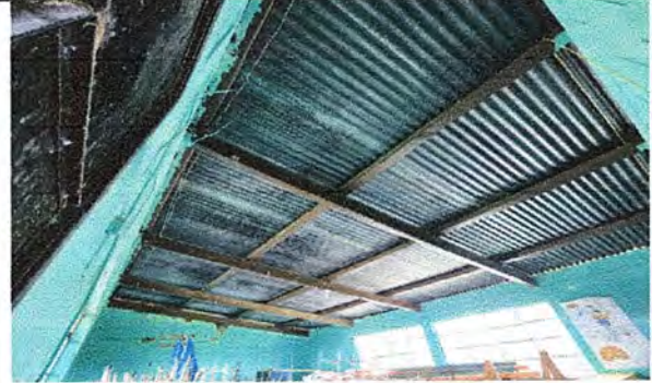
Foto 2: MODULO 1 SUSTITUCION DE ESTRUCTURA DE SOPORTE DE MADERA POR METAL
