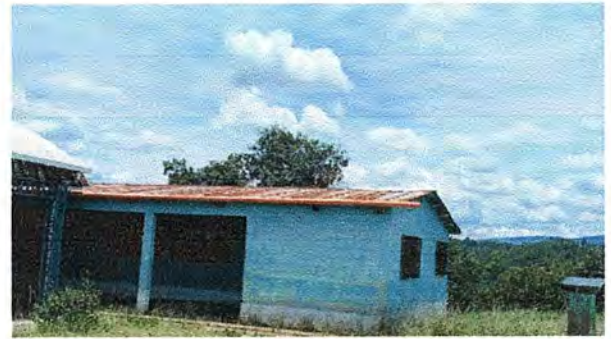
Foto 4: MODULO 1SUSTITUCION DE CANAL PVC
