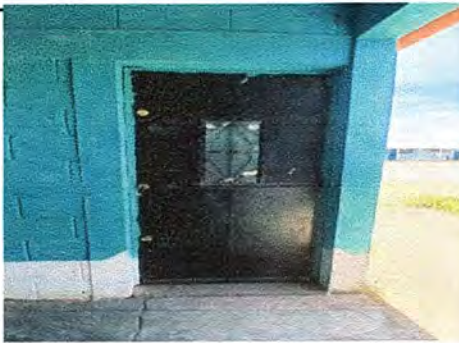
Foto 5: MODULO 1 MANTENIMIENTO A ESTRUCTURA DE PUERTA
