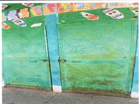
Foto 9: MODULO 3 MANTENIMIENTO A ESTRUCTURA DE PUERTA
