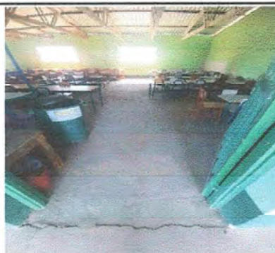
Foto 4: Modulo 4, sustitución de piso de torta de concreto por cerámica
