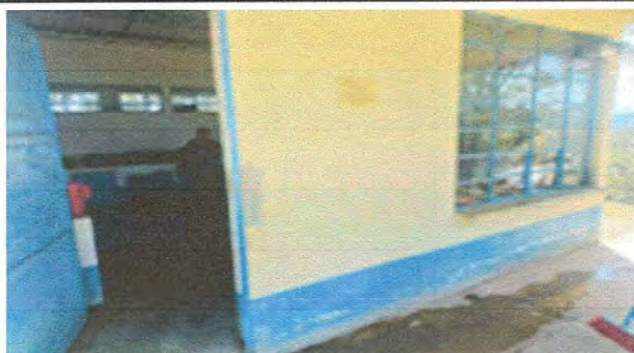
Foto 8: Pintura en paredes interiores y exteriores
