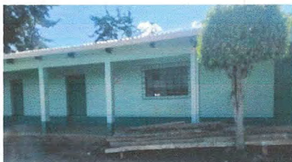
Foto 3: Modulo 4, Sustitución de puerta de madera por metal
