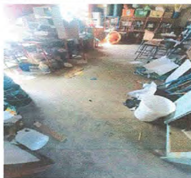
Foto 2: Modulo 3, sustitución de piso de torta de cemento por cerámica
