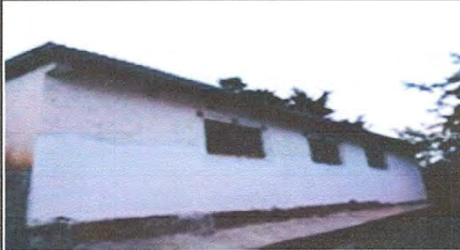
Foto 8: Pintura en paredes interiores y exteriores
