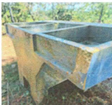
Foto 7: Modulo 6: Sustitución de pila de cemento de dos lavaderos por una de plástico
