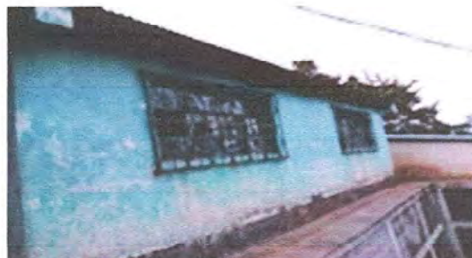
Foto 8: Pintura en paredes interiores y exteriores
