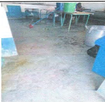
Foto 6: Modulo 5: sustitución de piso de torta de concreto por cerámica
