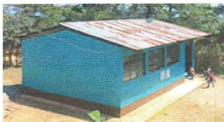
Foto 5: Modulo 5, sustitución de lámina, por lámina Troquelada Aluzinc calibre 26
