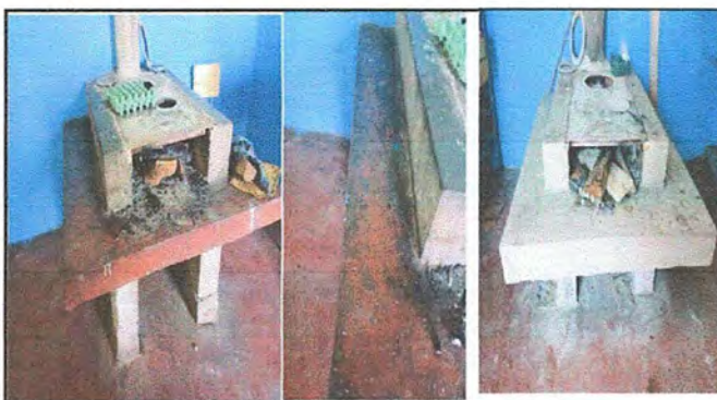
Foto 4. MÓDULO 2: Instalación de azulejos a Estufa Rural.
