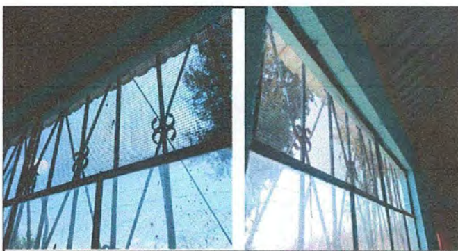
Foto 12. MÓDULO 4: Sustitución de ventana de metal a PVC.
