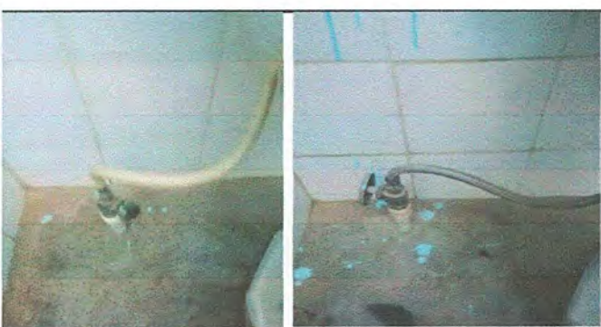
Foto 17. MÓDULO 5: Sustitución de accesorios de baño (contra llave, tubo de abasto y tanque).
