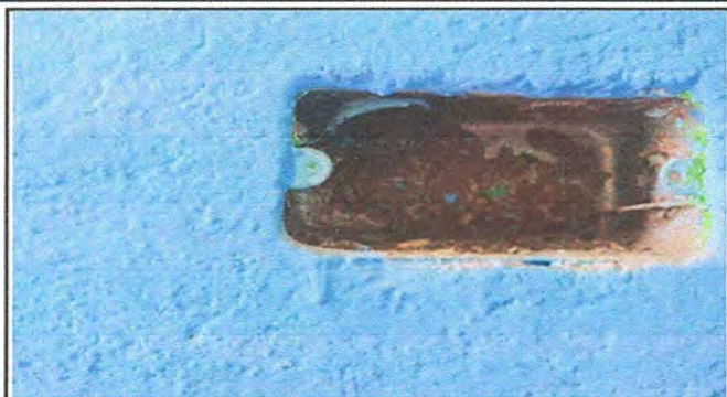
Foto 7. MÓDULO 2: Sustitución de tomacorriente doble.
