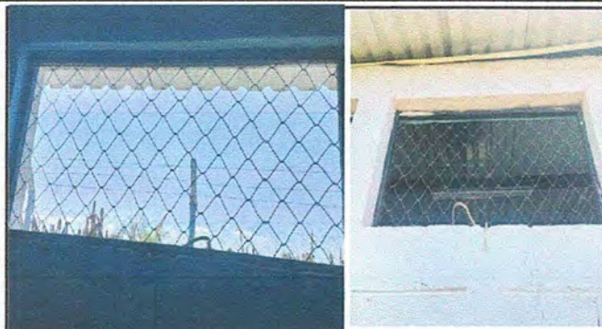
Foto 8. MÓDULO 2: Sustitución de estructura de metal de ventana (incluye vidrio)
