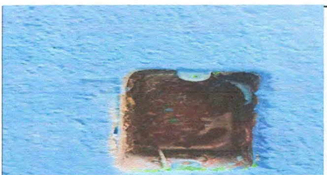
Foto 5. MÓDULO 2: Reparación cableado eléctrico.
