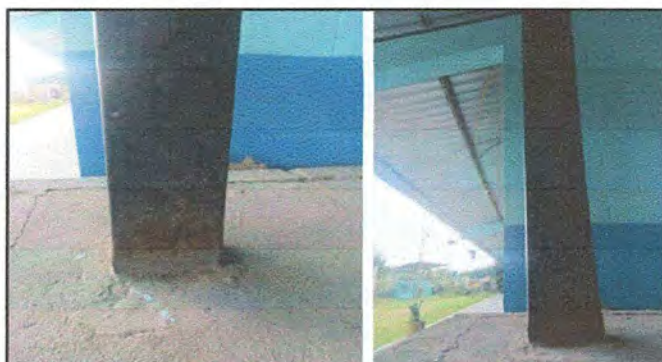
Foto 16. MÓDULO 4: Mantenimiento a estructura de soporte de metal.
