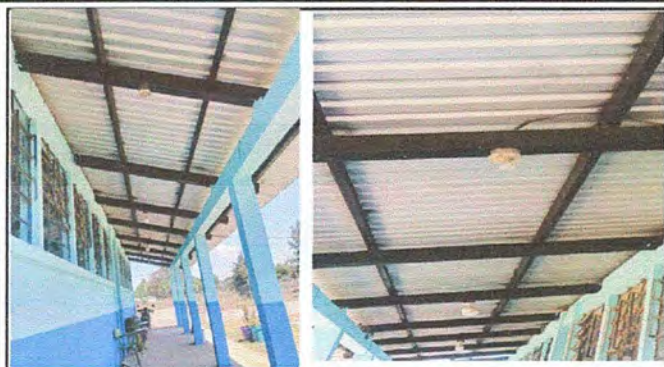
Foto 1. MÓDULO 1: Sustitución de focos ahorradores. Sustitución de piso de torta a cerámico.
