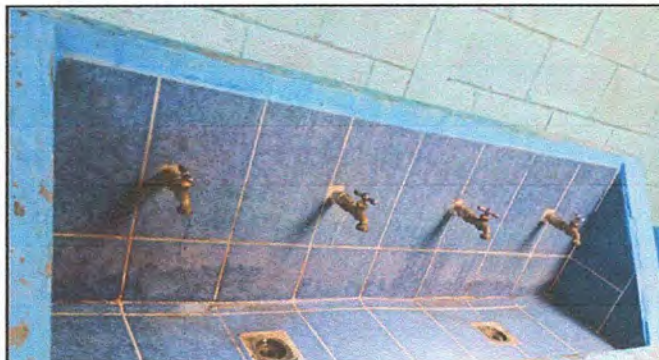
Foto 22. MÓDULO 5: Sustitución de grifos.
