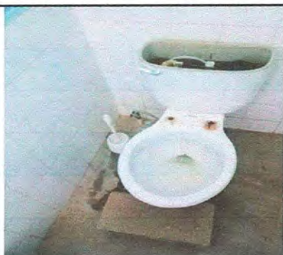
Foto 21. MÓDULO 5: Instalación de inodoro
