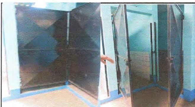
Foto 9. MÓDULO 2: Mantenimiento a estructura de puerta (fijado, cambio de tubo, cepillado, sujeciones, aplicación de pintura).
