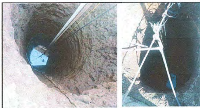
Foto 24. POZO ARTESANAL. instalación de tubo de concreto 42"
