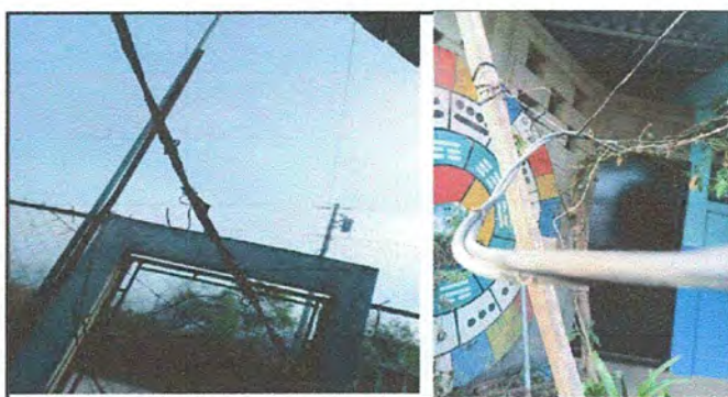
Foto 18. MÓDULO 5: Reparación cableado eléctrico.
