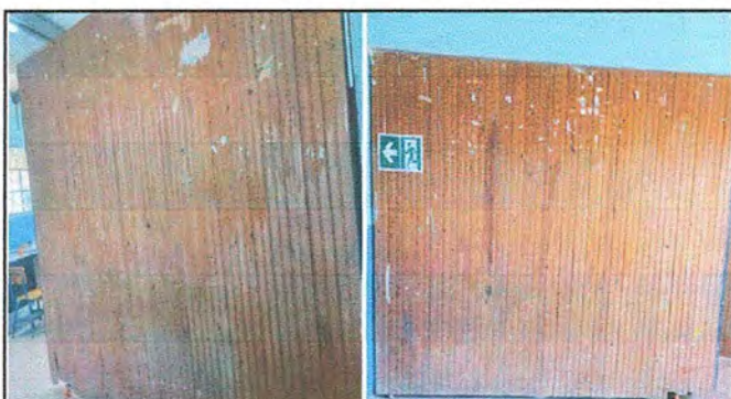
Foto 15. MÓDULO 4: Mantenimiento a estructura de muro divisorio (fijado, cambio de tubo, cepillado, sujeciones, plicación de pintura)
