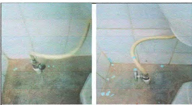
Foto 11. MÓDULO 2: Sustitución accesorio de baño (contra llave, tubo de abasto y tanque).
