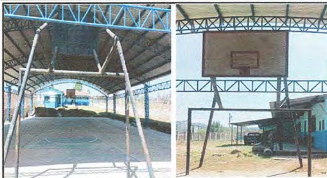
Foto 26. AREA EXTERIOR: Mantenimiento a estructura de portería (fijado, cambio de tubo, cepillado, sujeciones, plicación de pintura).
