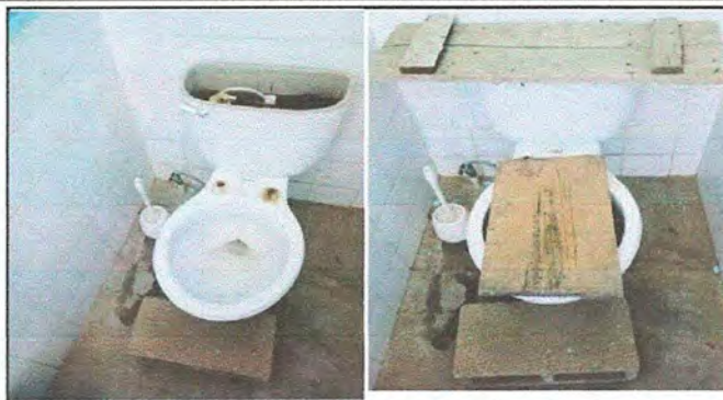
Foto 20. MÓDULO 5: Sustitución de inodoro.
