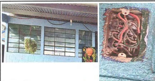
FOTOS 1 MÓDULO 3. Suministro y fabricación e instalación de balcones de hierro de ventana. Reparación de cableado eléctrico.
