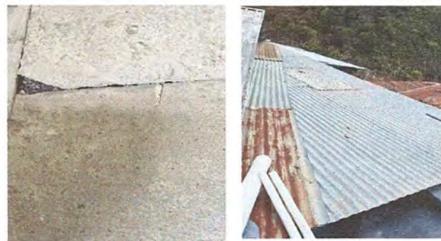
FOTOS 2 MÓDULO 1: Sustitución de lámina, por lámina troquelada aluzinc calibre 26. Sustitución de piso de torta de concreto por piso de granito
