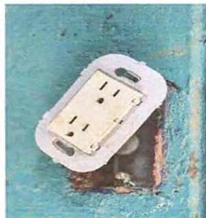
FOTOS 3 MÓDULO 3. Sustitución de tomacorrientes dobles. Suministro y sustitución de timbre (incluye interruptor, ducto y cable eléctrico).
