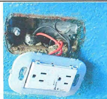
FOTOS 2 MÓDULO 4. Sustitución de tomacorrientes dobles. Reparación de cableado eléctrico.
