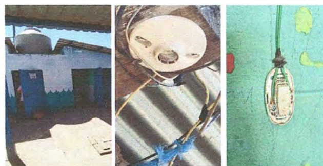
FOTOS 2 MÓDULO 2 BAÑOS: Mantenimiento a estructura de puerta (lijado, cambio de tubo, cepillado, sujeciones, aplicación de pintura). Sustitución de plafoneras. Sustitución de interruptores simples.
