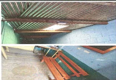
FOTOS 1 MÓDULO 1: Sustitución de estructura de soporte de madera, por metal. Repello en muro y Cernido en muro.
