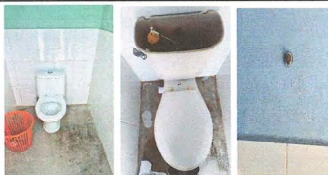
FOTOS 1 MÓDULO 2 BAÑOS: Sustitución inodoro. Sustitución inodoro pequeño. Sustitución de llave de mingitorio.
