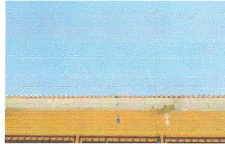
Foto 2. Módulo 1: Instalación de canales de pvc.
