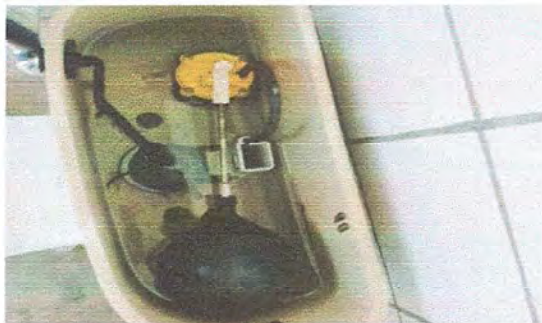
Foto 6. Baños: Sustitución de accesorios en inodoros (contra llave, tubo de abasto y tanque).
