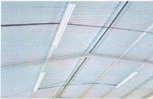
Foto 1. Módulo 1: Sustitución de lámparas 2x40.
