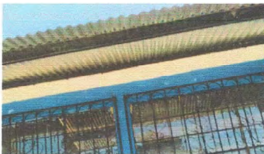
Foto 4. Módulo 2: Instalación de canales de pvc.
