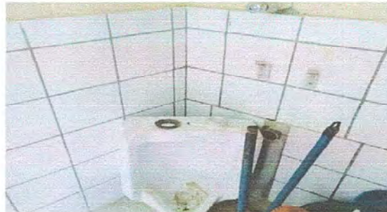
Foto 7. Baños: Sustitución de llave en migitorios.
