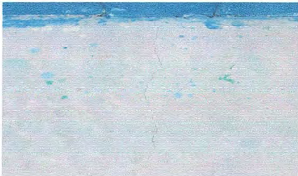
Foto 3. Módulo 2: Sustitución de piso de cemento líquido a piso cerámico.
