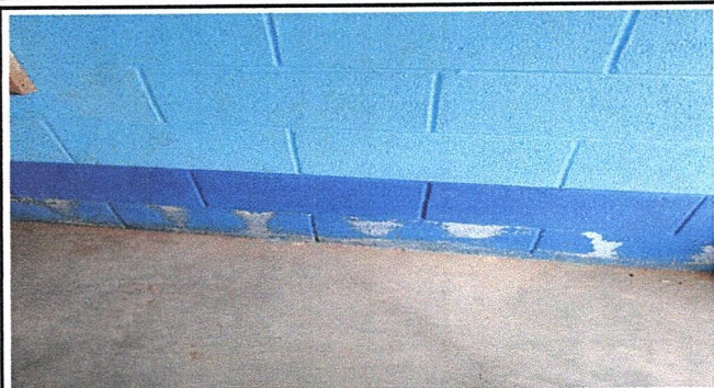
Foto 7: MODULO1: Pintura en muros exteriores e interiores
