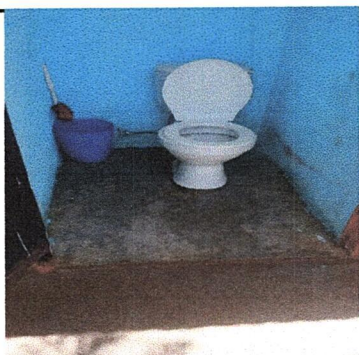
Foto 9: SERVICIOS SANITARIOS : Sustitución de piso de torta de concreto por piso cerámico y Suministro e instalación de azulejo en paredes
