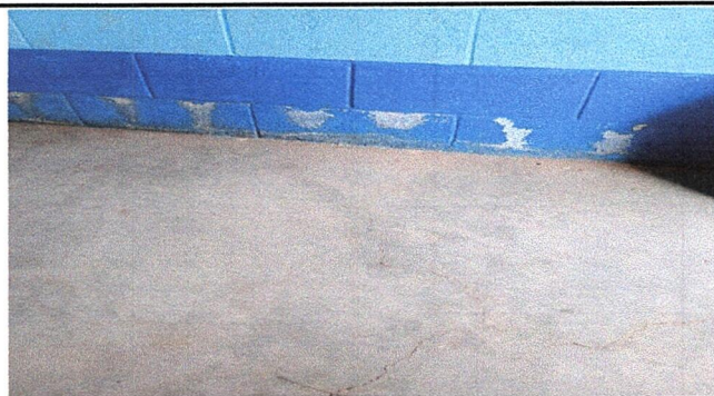
Foto 1: Módulo 1: Sustrucción de piso de torta de concreto por piso granito
