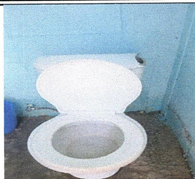
Foto 8: SERVICIOS SANITARIOS : Sustitución de inodoro
