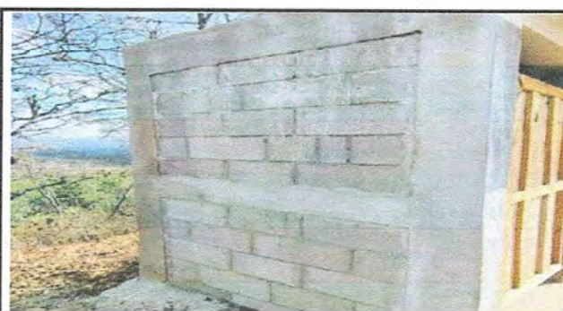
Foto 12: Módulo 3: REPELLO EN MUROS Y ALISADO EN MUROS
