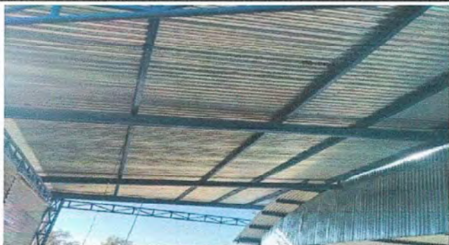
FOTO 1: MODULO 1: INSTALACION DE UNIDADES DE LUZ (INCLUYE INTERRUPTOR Y CABLES) E INSTALACION DE PLAFONERAS
