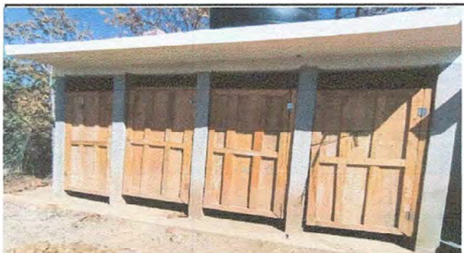
Foto 13: Modulo 3: SUSTITUCIÓN DE PUERTAS DE METAL
