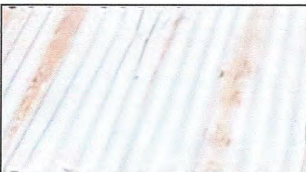
Foto 4: Modulo 2: SUSTITUCION DE LAMINA POR LAMINA TROQUELADA ALUZINC CALIBRE 26 Y SUSTITUCION DE DE ELEMENTOS DE FIJACION (TORNILLO)
