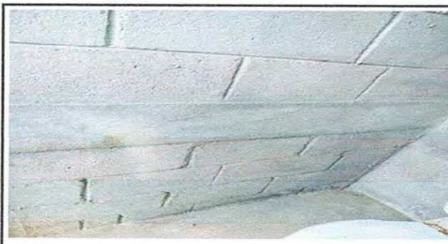
Foto 10: Módulo 3 SUSTITUCION DE AZULEJO
