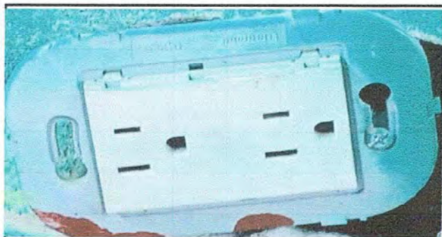
Foto 7: Módulo 2: SUSTITUCION DE TOMA CORRIENTE DOBLE
