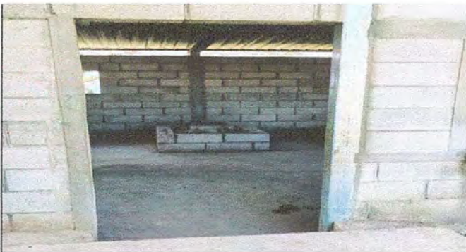
Foto 18: MODULO 5: SUMINISTRO E INTALACION DE PUERTA DE METAL
