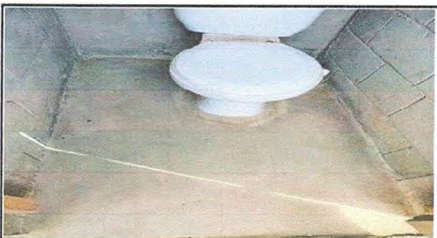
Foto 11: Módulo 3 : SUSTITUCION DE TORTA DE CONCRETO POR PISO CERAMICO
