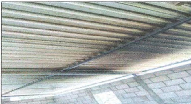
FOTO 16: MODULO 5: INSTALACION DE UNIDADES DE LUZ INCLUYE (INTERRUPTOR Y CABLES) Y SUMINISTRO DE PLAFONERAS
