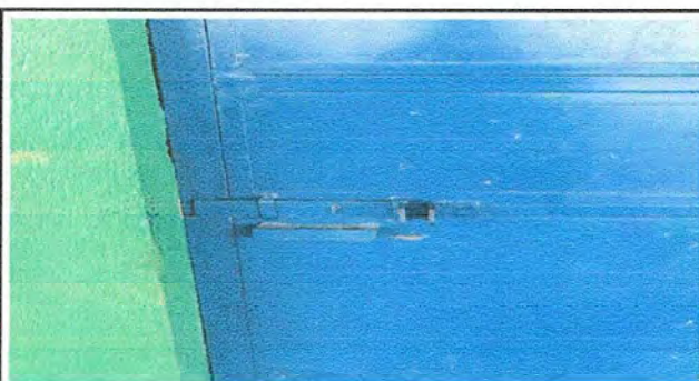
Foto 6: Modulo 2: SUMINISTRO Y FABRICACION DE CHAPA
