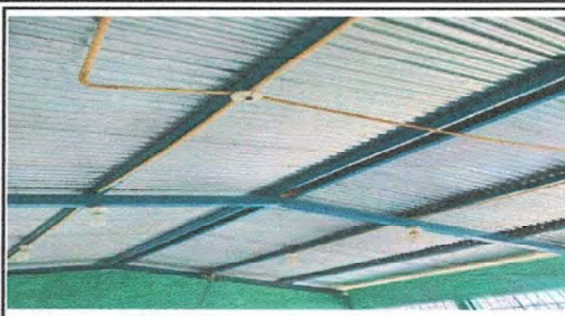
FOTO 2: MODULO 2: SUSTITUCIÓN DE FOCOS AHORRADORES Y SUSTITUCION DE CABLE ELECTRICO
