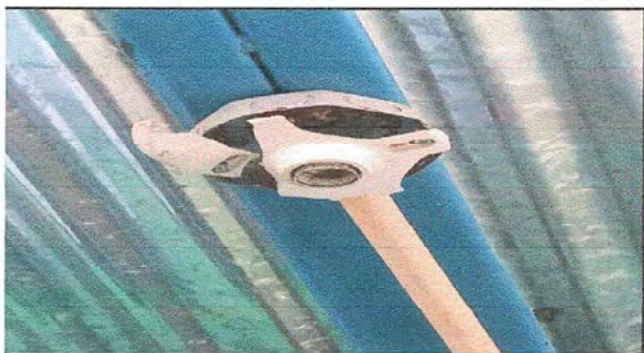
Foto 3: MODULO 2: SUSTITUCIÓN DE PLAFONERAS
