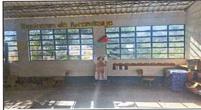
Foto 4: MODULO I: Sustitución de ventana de metal
