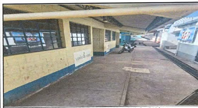
Foto 5: MODULO I: Suministro e instalación de balcón de hierro en ventana
