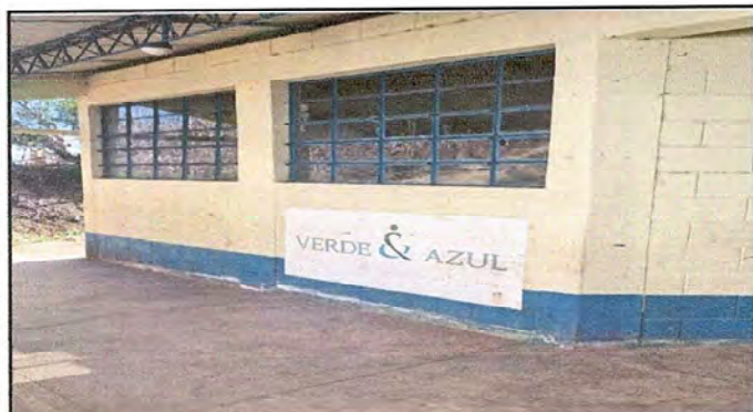
Foto 3: MODULO I: Sustitución de estructura de metal de ventana por PVC
