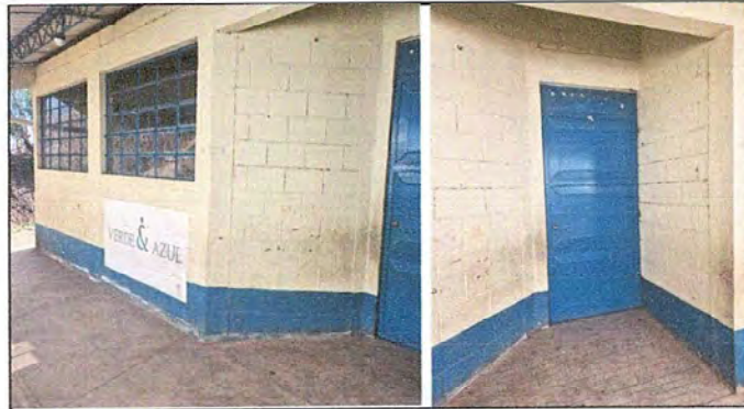
Foto 2: MODULO I: Pintura en muros exteriores e interiores
