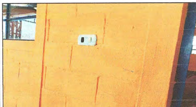
Foto3: MÓDULOS DE AULAS. Sustrucción de interruptores, cableado eléctrico.
