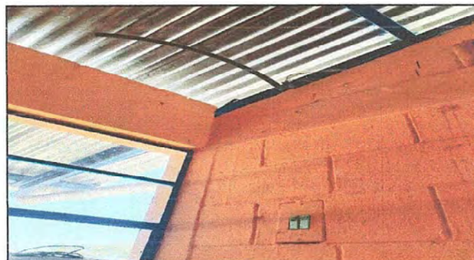
Foto4: MÓDULOS DE AULAS. Sustrucción de flpones.
