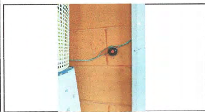
Foto 5: MÓDULOS DE AULAS. Sustrucción de timbre.
