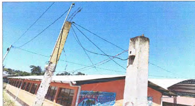
Foto10: CANCHA. Suministro e instalación de forro para cable sobre cancha.
