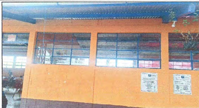
Foto13: Suministro e instalación de balcones en aulas (2 balcones).
