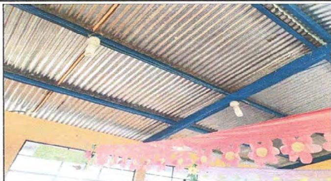
Foto1: MÓDULOS DE AULAS. Sustrucción de plafoneras, sustrucción de focos ahorradores, cableado eléctrico.
