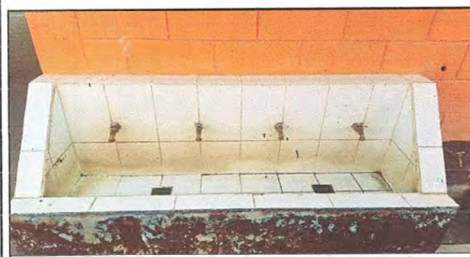
Foto11: BAÑOS. Sustrucción de azulejo en lavamanos de concreto. Sustrucción de llaves de chorro.
