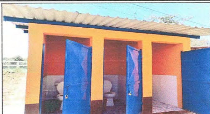
Foto7: BAÑOS. Sustrucción de plafoneras, focos ahorradores, interruptores, tomacorrientes, cableado eléctrico.
