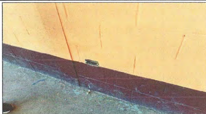
Foto2: MÓDULOS DE AULAS. Sustrucción de tomacorrientes, cableado eléctrico.
