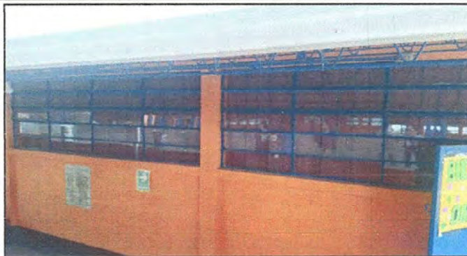
Foto14: Suministro e instalación de balcones en aulas (2 balcones).
