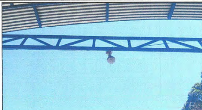
Foto8: CANCHA. Sustrucción de focos por reflectores (incluye interruptores, cableado eléctrico)
