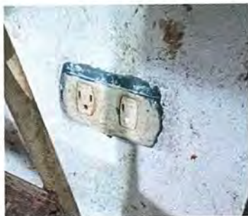
Foto 13: COCINA:SUSTITUCIÓN DE INTERRUPTORES Y TOMACORRIENTES
