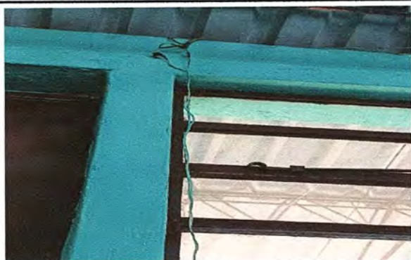
Foto 9: MODULO 1:REPARACIÓN DE CABLEADO ELECTRICO Y SUSTITUCIÓN DE DUCTO ELECTRICO + ACCESORIOS
