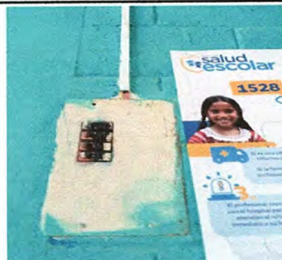
Foto 10: MODULO 1:SUSTITUCIÓN DE TABLERO ELECTRICO Y SUSTITUCIÓN DE FLIPONES
