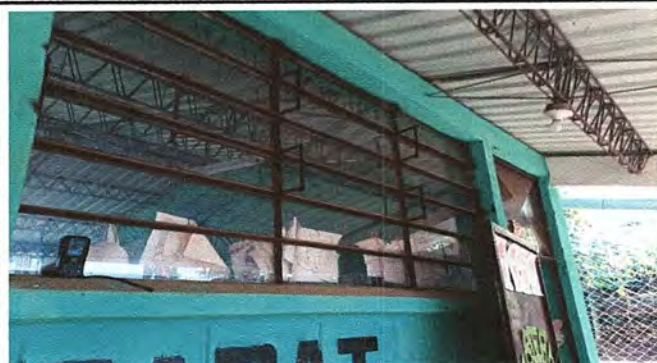
Foto 4: MODULO 1: SUMINISTRO E INSTALACIÓN DE BALCONES Y MANTENIMIENTO DE ESTRUCTURA DE VENTANA.
