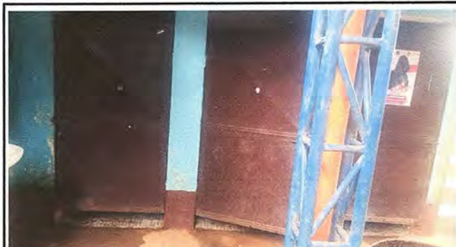
Foto 3: SANITARIOS: MANTENIMIENTO A ESTRUCTURA DE PUERTA (LIJADO, PINTADO)
