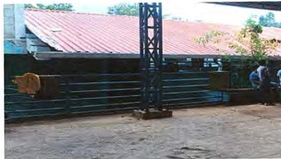
Foto 14: PATIO:MANTENIMIENTO DE BARANDA
