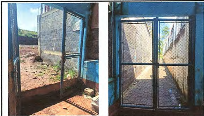
Foto1: MURO PERIMETRAL :MANTENIMIENTO A ESTRUCTURA DE PORTON (pintado y lijado) (1.99X2.47)
