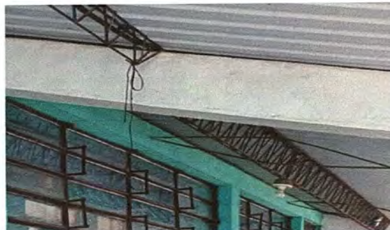
Foto 8: MODULO 1:SUMINISTRO E INSTALACIÓN DE TIMBRE Y SUMINISTRO DE INTERRUPTOR PARA TIMBRE
