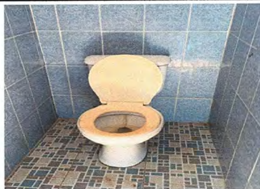
Foto 2: SANITARIOS : SUSTITUCIÓN DE INODOROS
