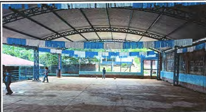
Foto 15: PATIO:SUMINISTRO E INSTALACIÓN DE TOMACORRIENTES, CABLEADO Y DUCTO.
