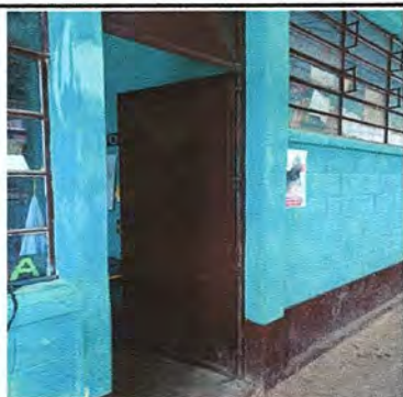
Foto 5: MODULO 1: MANTENIMIENTO A ESTRUCTURA DE PUERTA (LIJADO, PINTADO, INCLUYE CORTE DE PUERTA)
