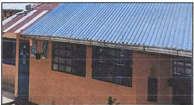
Foto 6: Sustitución de canal de PVC
