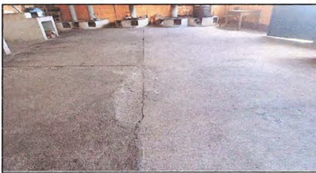
Foto 5: Módulo 1 Sustitución de torta de concreto por piso de granito
