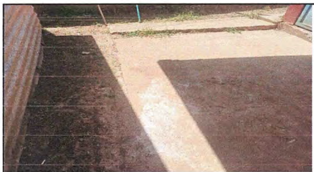
Foto 9: Módulo 2 Reparación de banqueta
