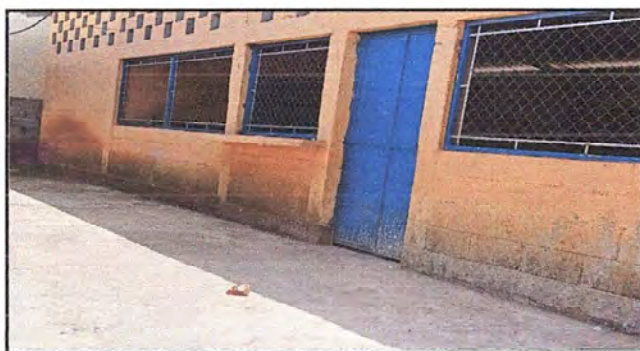
Foto 11: Pintura General, pintura de módulos exteriores e interiores
