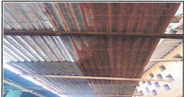
Foto 2: Módulo 1 Sustitución de estructura de soporte de madera, por metal
