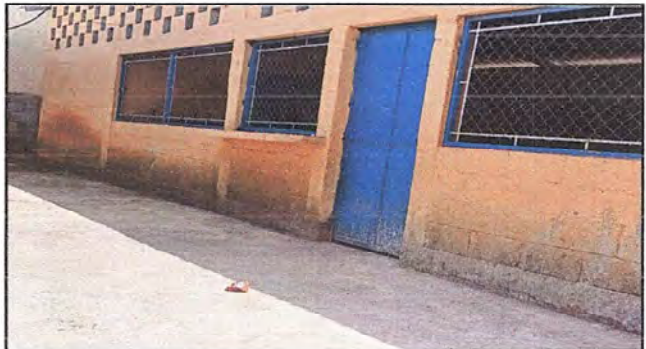
Foto 4: Módulo 1 Mantenimiento a puertas de metal
