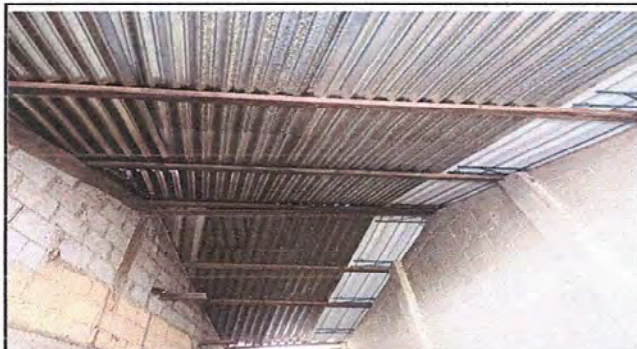
Foto 3: Módulo 1 Sustitución de estructura de soporte de madera por metal
