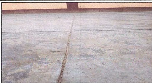
Foto 7: Módulo 2 Sustitución de piso de torta por piso cerámico
