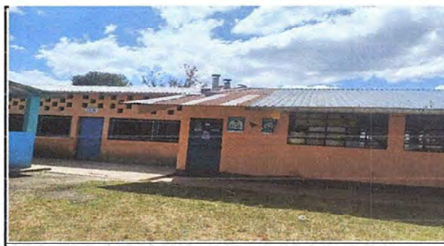
Foto 12: Pintura General, pintura de módulos exteriores e interiores
