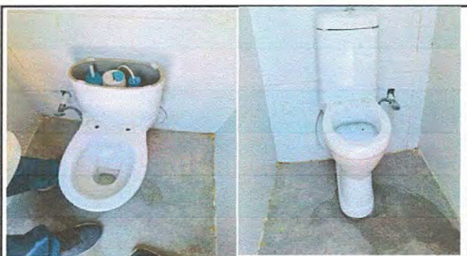
FOTO 9 MODULO 6: *Sustitución de accesorios de inodoro(contrallave, tubo de abasto y tanque). * Sustitución inodoro.
