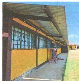
FOTO 2 MODULO 2: *Sustitución de canal pvc. *Sustitución de soporte o pescante pvc para canal
