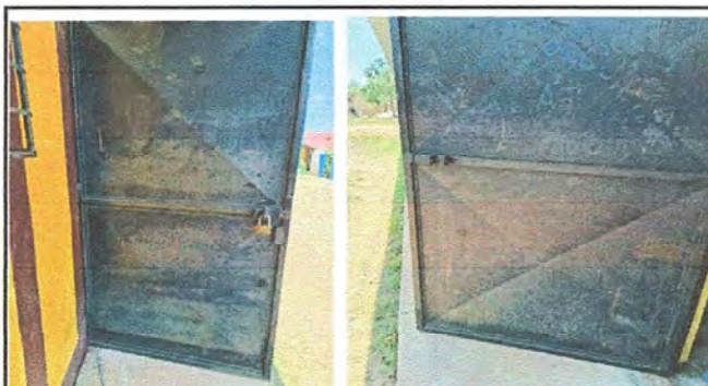
FOTO 4 MODULO 2: Mantenimiento a estructura de puerta (lijado, cambio de tubo, cepillado, sujeciones, aplicación de pintura).
