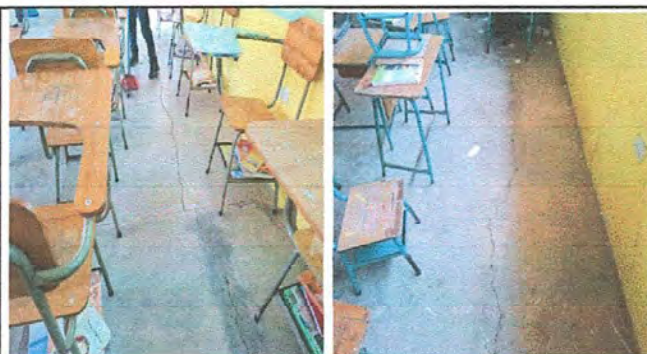
FOTO 3 MODULO 2: Sstitución de piso de torta de concreto.
