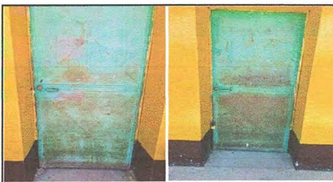
FOTO 6 MODULO 4: Mantenimiento a estructura de puerta (lijado, cambio de tubo, cepillado, sujeciones, aplicación de pintura).
