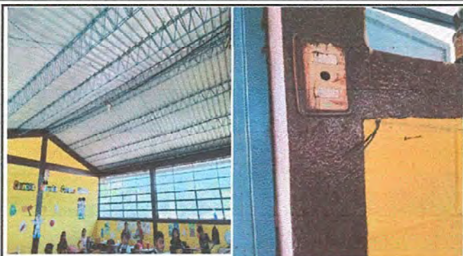
FOTO 7 MODULO 5: Sustitución de lámpara tipo LED. * Sustitución de plafonera. * Sustitución de interruptores simples. * Sustitución de tomacorriente doble. * Sustitución de ducto eléctrico mas accesorios. Reparacion de
