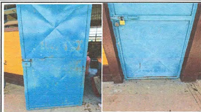
FOTO 8 MODULO 5: Mantenimiento de estructura de puerta (lijado, cambio de tubo, cepillado, sujeciones, aplicación de pintura).
