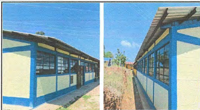
FOTO 1 MODULO1: *Sustitución de canal pvc. *Sustitución de soporte o pescante pvc para canal *Suministro, fabricación e intalación de balcón de hierro en ventana.
