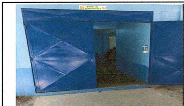
Foto15: MÓDULO 6. Suministro de puerta tipo reja.
