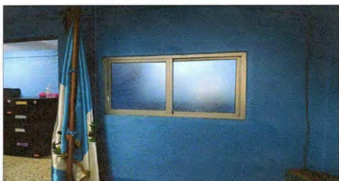
Foto 5: MÓDULO 1. Sustitución de ventanilla de aluminio (dirección)
