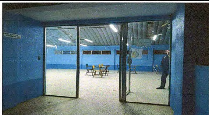
Foto1: MÓDULO 1. Sustitución de puerta de aluminio por puerta de metal tipo reja y reparación de pañuelos en losa sobre puerta
