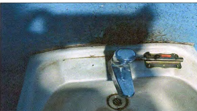
Foto4: MÓDULO 1. Sustitución de grifos.
