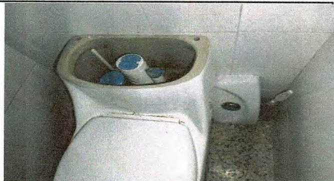
Foto8: MÓDULO 2. Sustitución de accesorios de inodoro.
