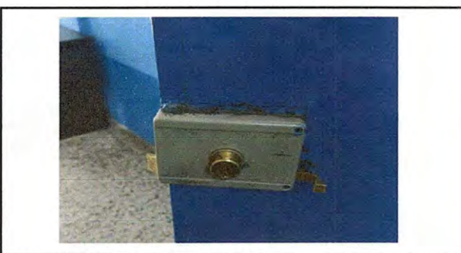
Foto 6: MÓDULO 1. Sustitución de chapa
