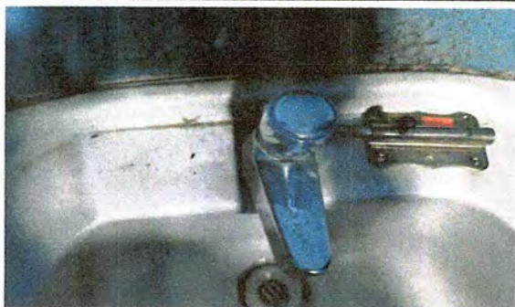
Foto9: MÓDULO 2. Sustitución de grifo
