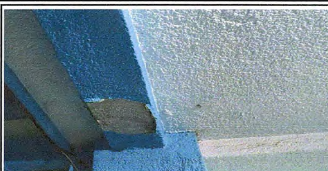
Foto2: MÓDULO 1. Reparación de pañuelos
