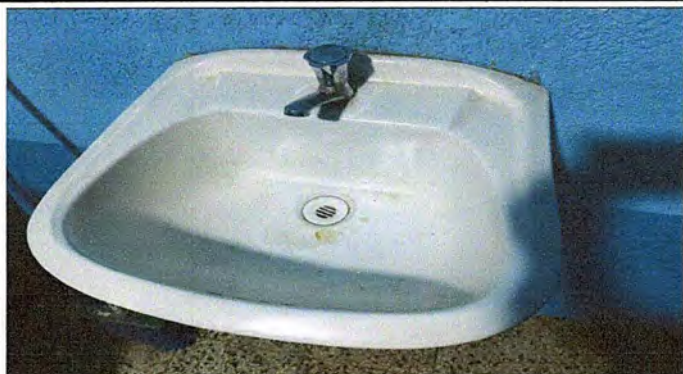
Foto13: MÓDULO 3. Sustitución de lavamanos.
