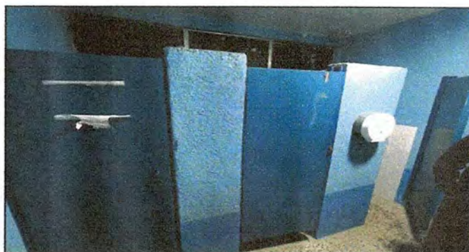
Foto12: MÓDULO 3. Sustitución de puertas de metal.
