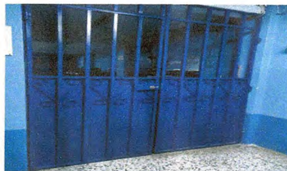
Foto10: MÓDULO 2. Sustitución de puerta tipo reja
