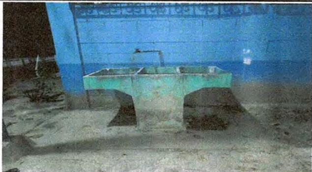
Foto7: MÓDULO 2. Sustitución de pila de cemento de dos lavaderos y caja de registro
