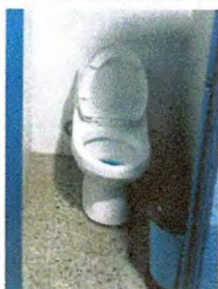
Foto11: MÓDULO 3. Sustitución de accesorios de inodoro.
