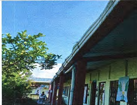
Foto 2: MODULO 1: SUSTITUCIÓN DE CANAL DE PVC Y SUSTITUCIÓN DE BAJADAS DE AGUA PLUVIAL
