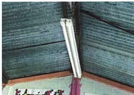
Foto 3: MODULO 1: SUSTITUCIÓN DE FOCO AHORRADOR
