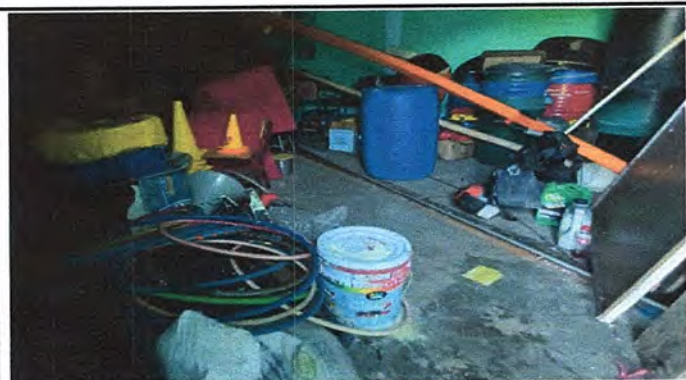
Foto 9: MODULO 4: SUSTITUCIÓN DE TORTA DE CONCRETO POR PISO CERAMICO
