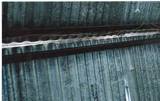
Foto 4: MODULO 1: REPARACIÓN DE CABLEADO ELECTRICO Y DUCTO ELECTRICO
