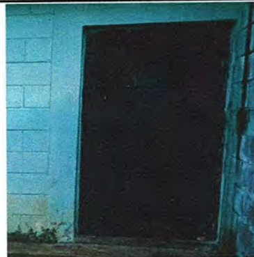
Foto 10: MODULO 4: MANTENIMIENTO DE PUERTA
