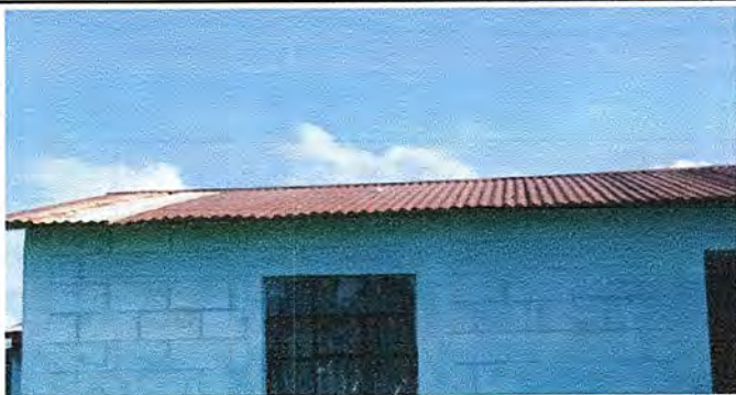
FOTO 15. MODULO 4: SUSTITUCIÓN CANAL PVC
