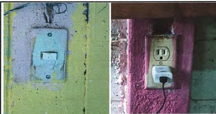
Foto 5: MODULO 1: SUSTITUCIÓN DE INTERRUPTOR Y TOMACORRIENTES
