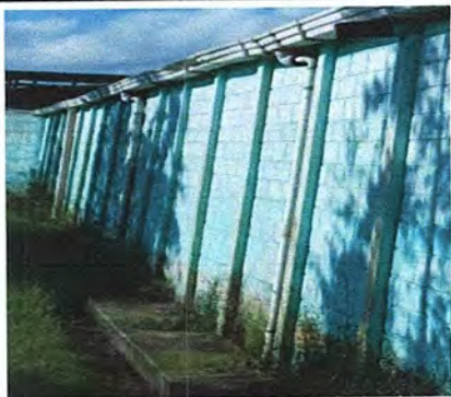
Foto 7: Modulo 2: SUSTITUCIÓN DE BAJADAS DE AGUA PLUVIAL PVC DE 3"
