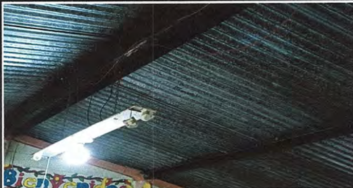
Foto 1: MODULO 1: Sustitución de lamina por lamina troquelada, sustitución de capote, sustitución de elementos de fijación.
