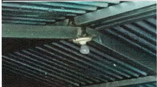
Foto 14: MODULO 4: SUSTITUCIÓN DE FOCO AHORRADOR Y PLAFONERA
