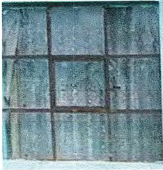
Foto 13: Modulo 4: SUSTITUCIÓN DE VIDRIO
