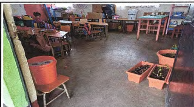
Foto 2: Módulo 2: SUSTITUCIÓN DE PISO DE TORTA DE CONCRETO POR PISO CERAMICO
