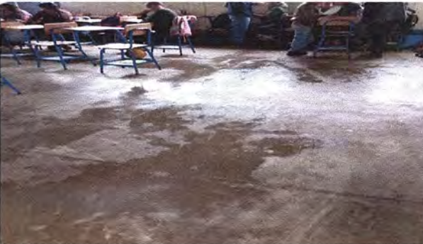
Foto 4: Módulo 2: SUSTITUCIÓN DE PISO DE TORTA DE CONCRETO POR PISO CERAMICO
