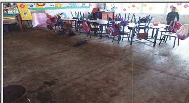
Foto 1: Módulo 1: SUSTITUCIÓN DE PISO DE FIBROCEMENTO POR PISO TIPO VINIL ADHESIVO
