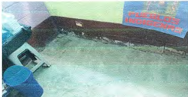
Foto 1: MODULO 1: Sustitución de piso de torta de concreto por piso de granito
