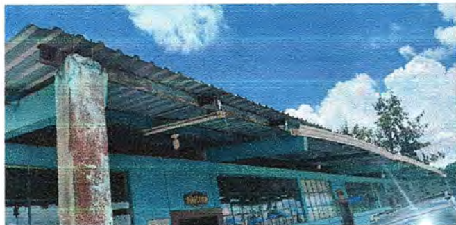
Foto 3: MODULO 1: Sustitucion de canales de pvc por canales de metal.
