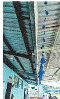
Foto 8: MODULO 2: Sustitución de soporte o pescante de metal para canal.
