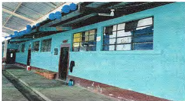
Foto 9: MODULO 2: Suministro e instalación de balcon de hierro en ventana.
