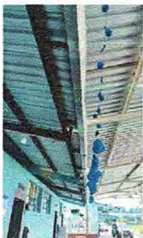
Foto 7: MODULO 2: Sustitucion de canales de pvc por canales de metal.
