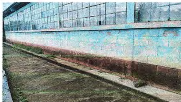
Foto 10: Pintura en muros exteriores.
