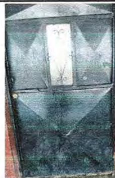
Foto 6: MODULO 2: Mantenimiento a estructura de puerta de puerta (lijado, cambio de tubo, cepillado, sujeciones, aplicación de pintura.)
