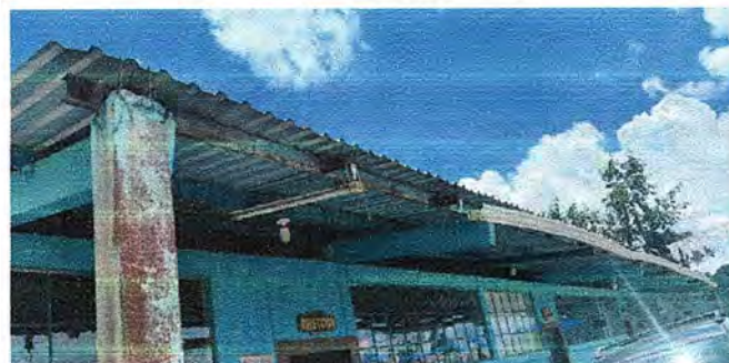
Foto 4: MODULO 1: Sustitución de soporte o pescante de metal para canal.
