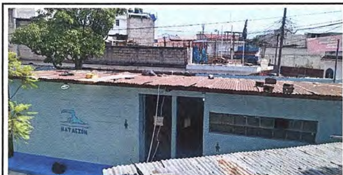
Foto 5: Modulo 3. Sustitución de lamina,
