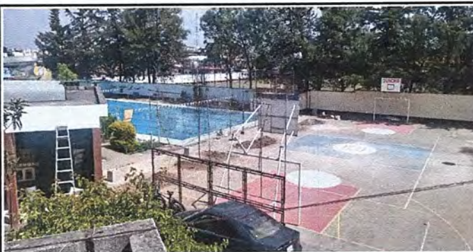
Foto 11: Área externa. Reparación de tubo y malla que divide entre edificio y cancha polideportiva.
