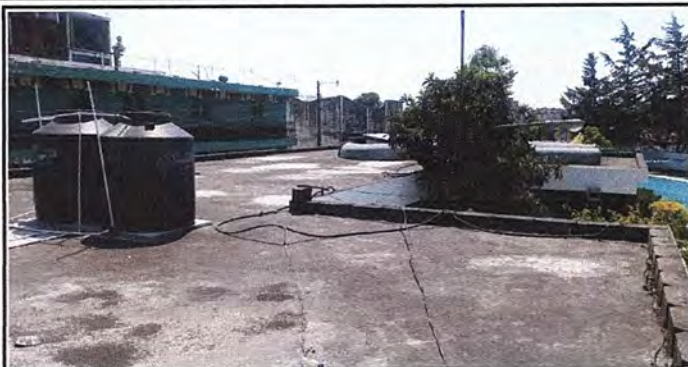
Foto1: Modulo 1. Impermeabilización de techo.
