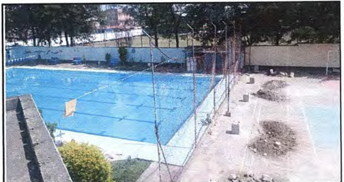
Foto 10: Área externa. Reparación de tubo y malla que divide la piscina y cancha polideportiva.
