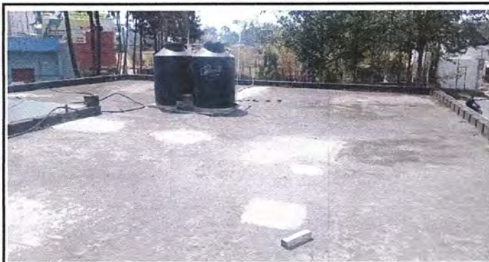
Foto 3: Modulo 1. Reparación de pañuelo.
