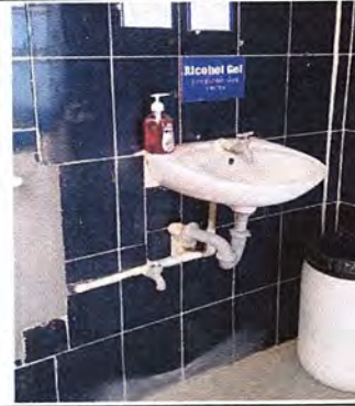
Foto 8: Modulo 3. Sustitución de lavamanos.
