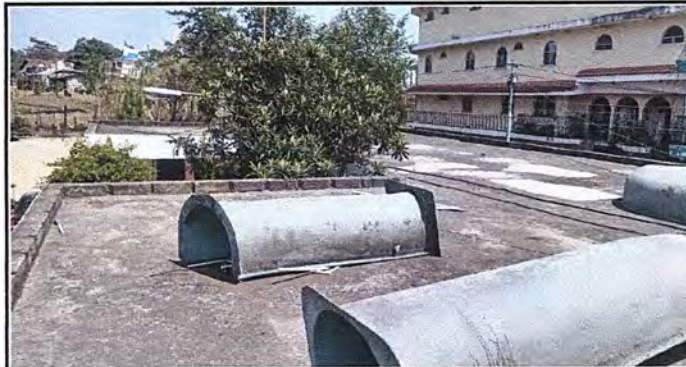
Foto 2: Modulo 1. Otra perspectiva de la impermeabilización de techo.
