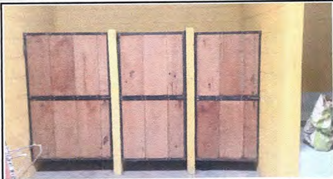
Foto7: Modulo 3. Puertas de servicios sanitarios 3 en vestidores de hombres y 3 en la de mujeres.
