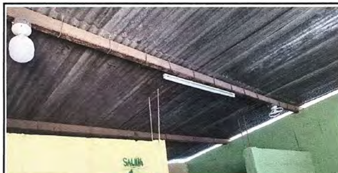
Foto 6: Modulo 3. Mantenimiento a estructura de soporte de metal.
