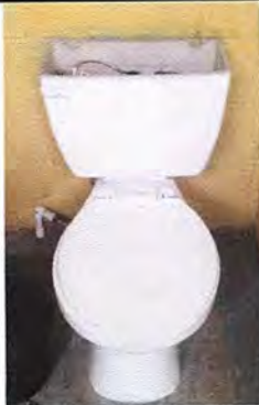
Foto 9: Modulo 3. Sustitución de servicios sanitarios 2 en vestidores de hombres y 2 en vestidores de mujeres.
