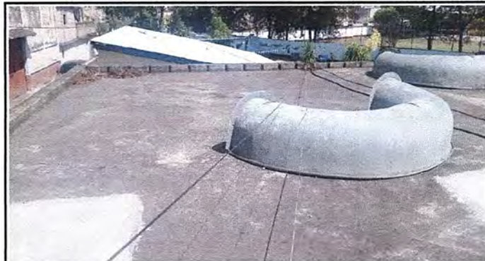
Foto 4: Modulo 1. Reparación de pañuelo.
