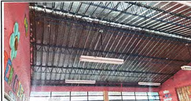
Foto 2: MODULO 1: MATENIMIENTO DE ESTRUCTURA PORTANTE.
