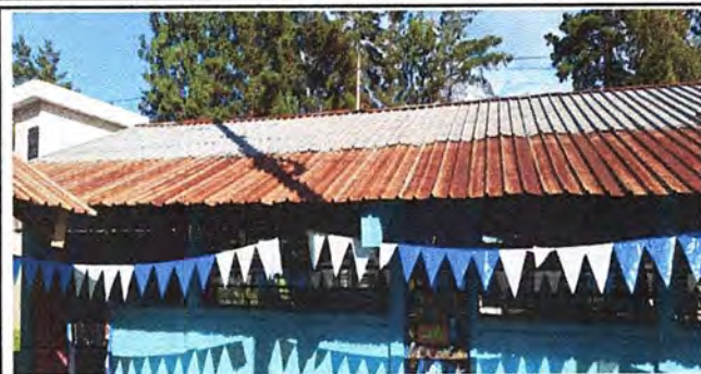
Foto 1: MODULO 1: SUSTITUCIÓN DE LAMINA POR LAMINA TROQUELADA ALUZINC CALIBRE 26, SUSTITUCIÓN DE ELEMENTOS DE FIJACIÓN TORNILLOS Y SUSTITUCIÓN DE CAPOTE
