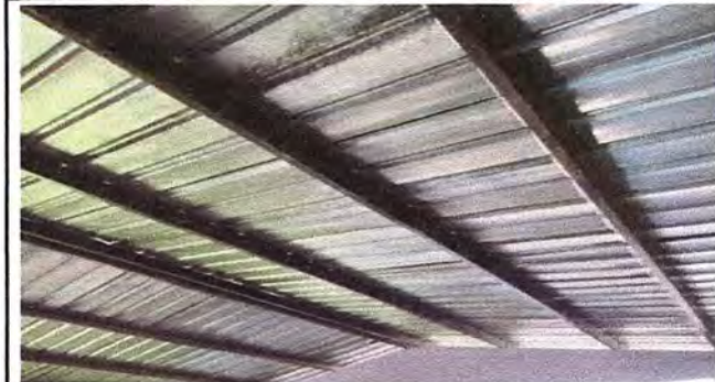
Foto 4: MODULO 2: MATENIMIENTO DE ESTRUCTURA PORTANTE.
