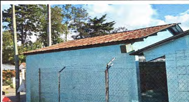
Foto 3: MODULO 2: SUSTITUCIÓN DE LAMINA POR LAMINA TROQUELADA ALUZINC CALIBRE 26, SUSTITUCIÓN DE ELEMENTOS DE FIJACIÓN TORNILLOS Y SUSTITUCIÓN DE CAPOTE
