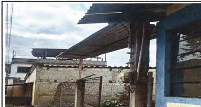
Foto 6: MURO PERIMETRAL: SUSTITUCIÓN DE LAMINA POR LAMINA TROQUELADA ALUZINC, SUSTITUCIÓN DE ESTRUCTURA DE SOPORTE DE MADERA POR METAL, SUMINISTRO DE CAPOTE Y SUSTITUCIÓN DE TORNILLOS.
