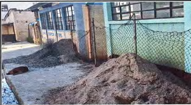
Foto 7: MURO PERIMETRAL: SUSTITUCIÓN DE MALLA GALVANIZADA Y TUBO HG
