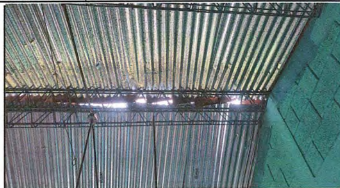
FOTO 2, MODULO 1: sustitucion de capote de lamina para lamina troquelada
