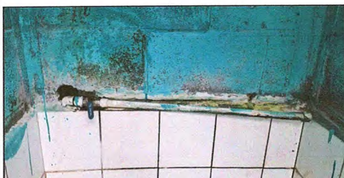
SANITARIO: Sustitucion de llave de paso
