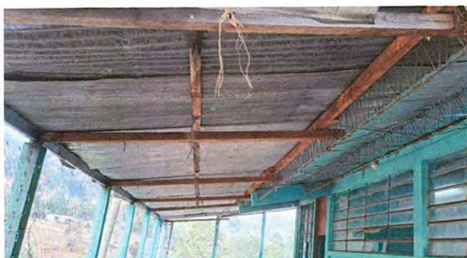
FOTO 3, MODULO 1: Sustitucion de estructura de soporte de metal por metal
