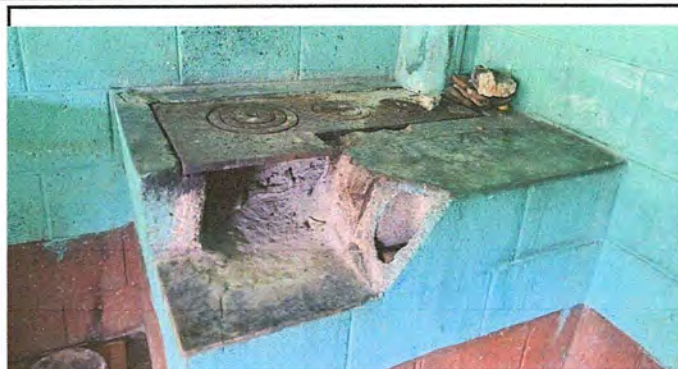
FOTO 8, COCINA: Sustitucion de estufa Rural (completa) incluye chimenea y plancha de metal
