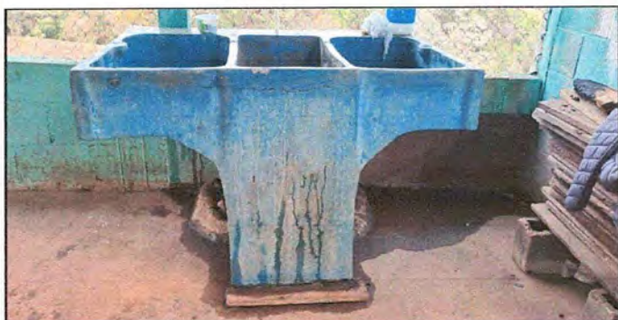
FOTO 9, Sustitucion de pila de Cemento de dos lavadero
