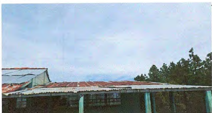
FOTO 5, Modulo 2 : sustitucion de laminas troqueladas calibre 26 y sustitucion de elementos de fijacion
