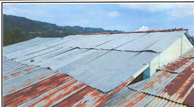
FOTO 1, MODULO 1: sustitucion de lamina troqueladas aluzinc calibre 26, sustitucion de elemnto de fijacion..
