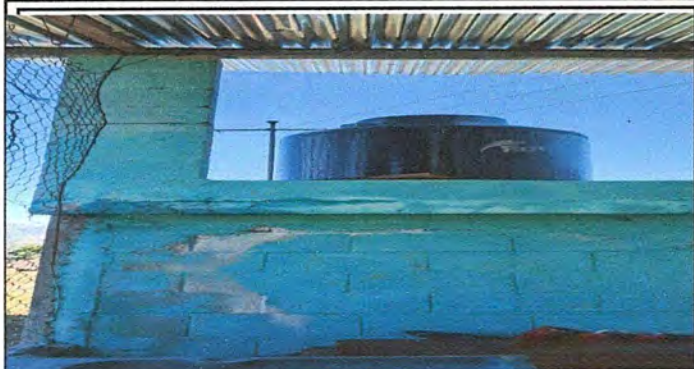
FOTO 7: pintura de muros exteriores e interiores
