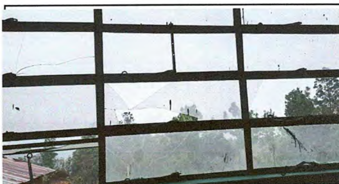
FOTO 4, MODULO 1: sustitucion de vidrio
