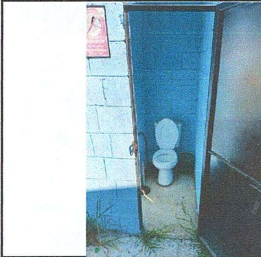
Foto 1: Modulo 1: Sustitución de torta de concreto por piso ceramico, suministro e instalación de azulejo.
