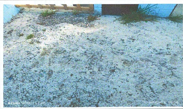
Foto 6: PATIO: Reparación de torta de concreto de patio.
