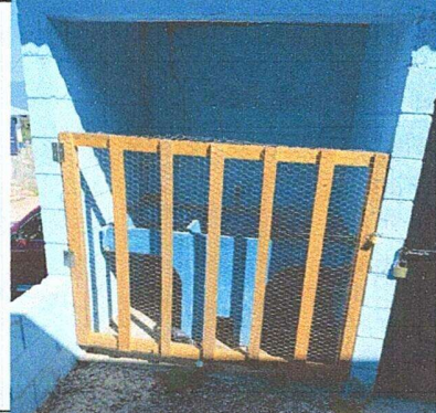
Foto 2: MODULO 1: Suministro e instalacion de puerta de metal.
