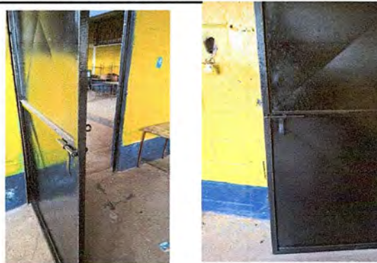
FOTO 8: MODULO 1: SUMINISTRO E INSTALACIÓN DE CHAPA
