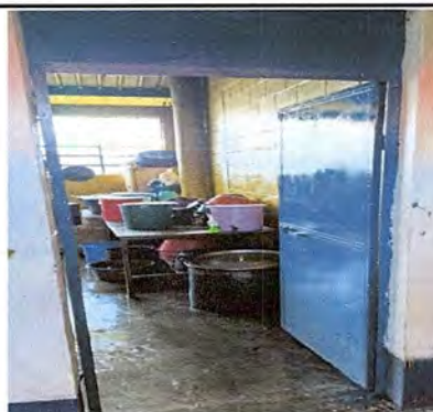
FOTO 16: MODULO 2: SUSTITUCIÓN DE PUERTA DE METAL (0.89X2.35)
