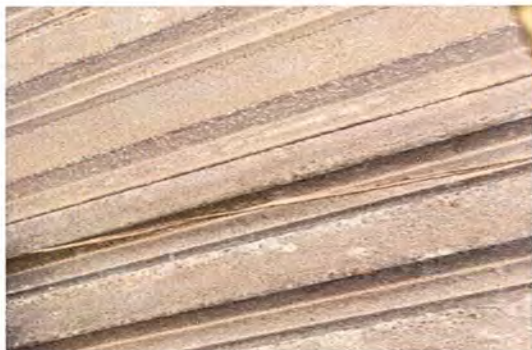
FOTO 13: MODULO 1: REPARACIÓN DE CABLEADO ELECTRICO
