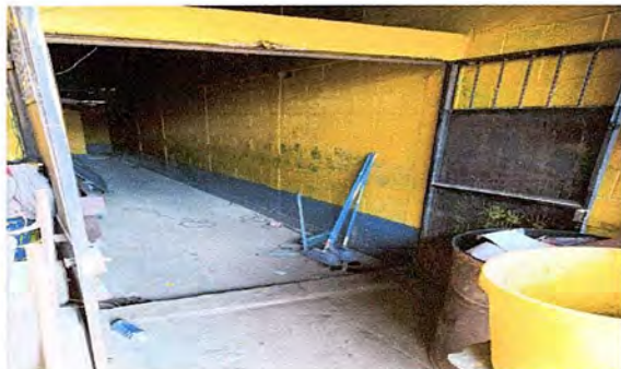
FOTO 7: MODULO 1: SUSTITUCIÓN DE PUERTA DE DOBLE HOJA(1.60X2.10)
