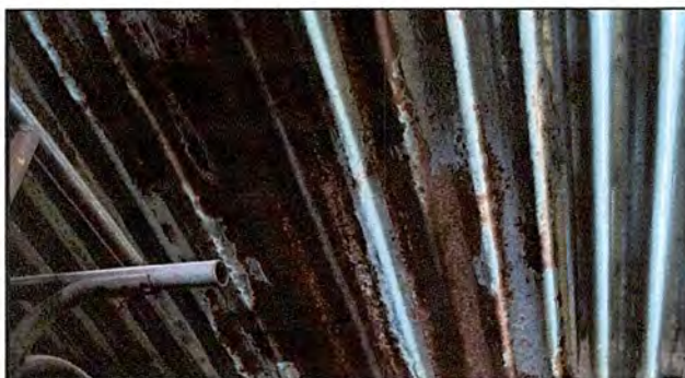
FOTO 5: MODULO 1: SUSTITUCIÓN DE LAMINA POR LAMINA TROQUELADA ALUZINC CALIBRE 26.
