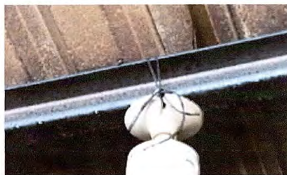
FOTO 12: MODULO 1: SUSTITUCIÓN DE PLAFONERA
