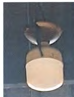
FOTO 18: MODULO 2: SUSTITUCIÓN DE PLAFONERA
