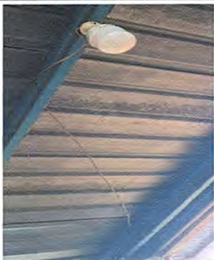
FOTO 19: MODULO 2: REPACACIÓN DE CABLEADO ELÉCTRICO
