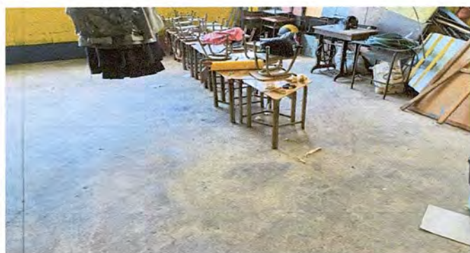
FOTO 9: MODULO 1: SUSTITUCIÓN DE PISO DE TORTA DE CONCRETO POR PISO CERAMICO
