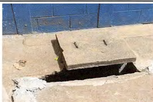
FOTO 4: AREA EXTERIOR: SUSTITUCIÓN DE TAPADERA DE CONCRETO.
