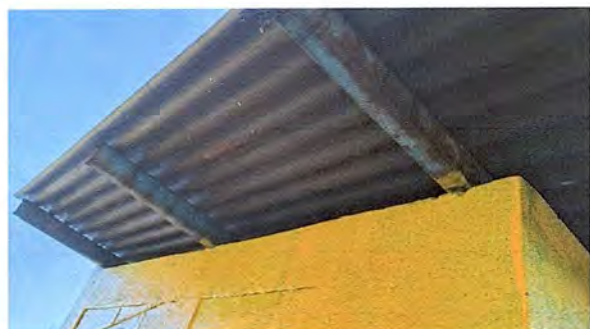
FOTO 21: MODULO 2: MANTENIMIENTO A ESTRUCTURA PORTANTE
