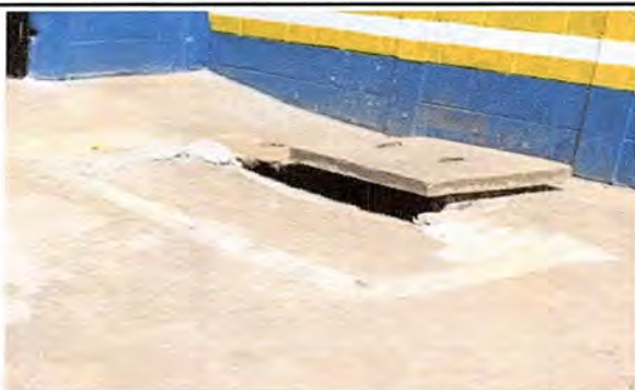
FOTO 3: AREA EXTERIOR: REPARACIÓN DE FOSA SEPTICA.
