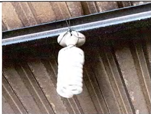
FOTO 11: MODULO 1: SUSTITUCIÓN DE FOCO AHORRADOR
