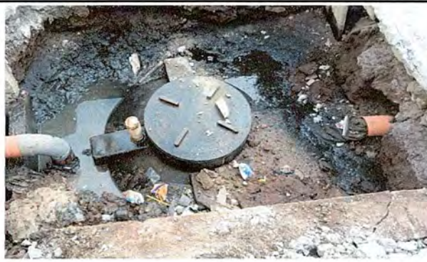
FOTO 2: AREA EXTERIOR: SUSTITUCIÓN DE BIODIGESTOR DE 1300 LTS
