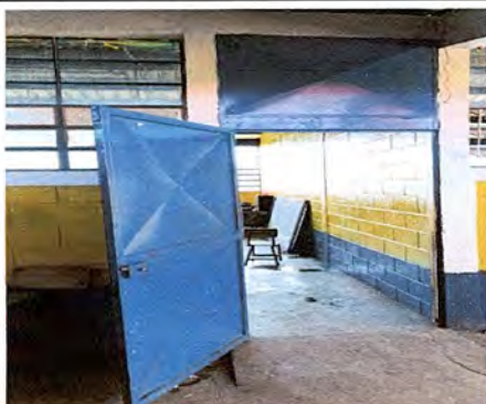
FOTO 15: MODULO 2: SUSTITUCIÓN DE PUERTA DE METAL (1.03X3M)
