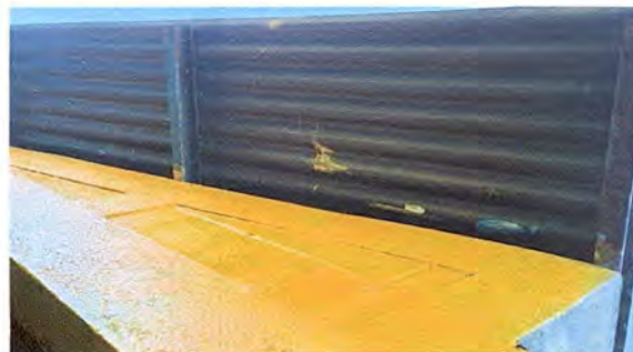
FOTO 20: MODULO 2: SUSUTITUCIÓN DE LÁMINA POR LÁMINA TROQUELADA ALUZINC CAL. 26
