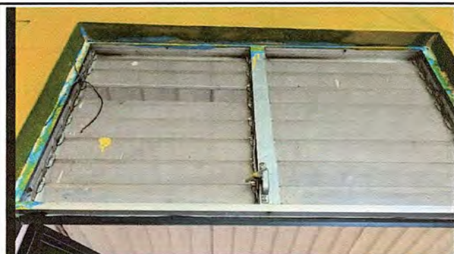
FOTO 10: MODULO 1: SUSTITUCIÓN DE VENTANA DE METAL POR VENTANA DE PVC
