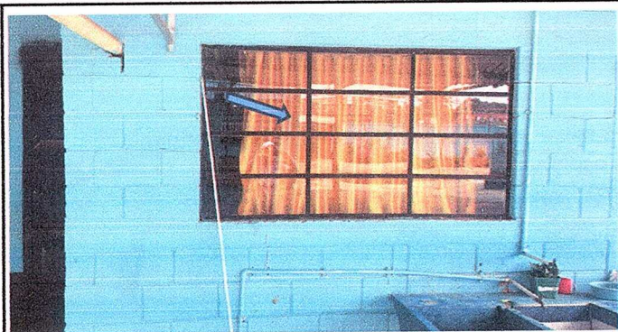
Modulo 1, foto 1: Sustitución e instalación de balcon de hierro en ventana
