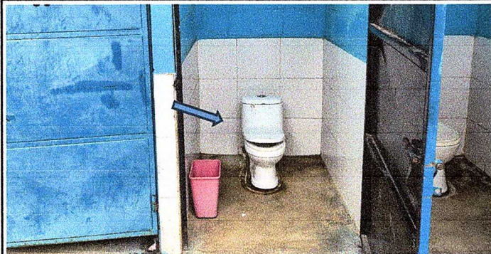
Sanitarios: foto 13: sustitución de inodoro baby
