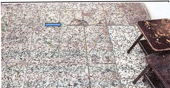
Modulo 2, foto 1: Sustitución de piso de granito por piso ceramico
