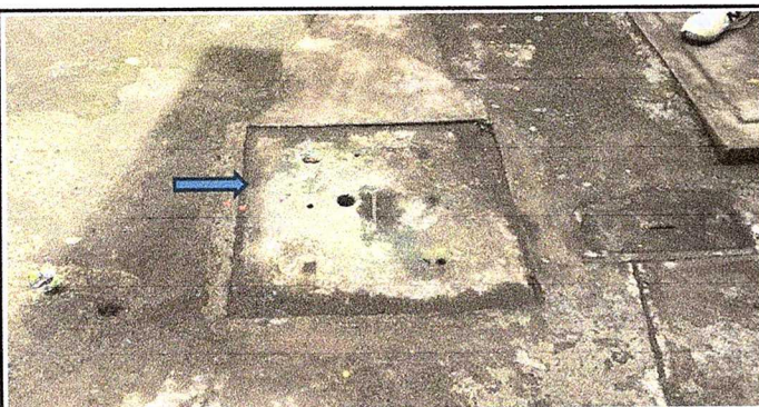
Patio, foto 9: Sustitucion de Reposadera
