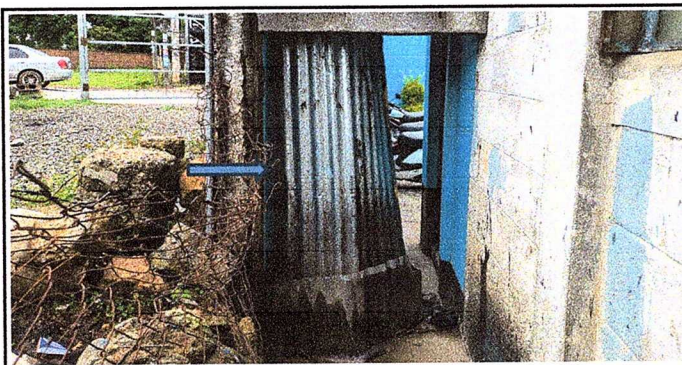
Patio, foto 11: Suministro e instalacion de puerta de metal (0.94 x 1.92)m
