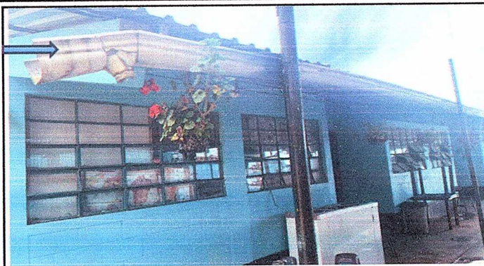
Modulo 1, foto 2: Sustitución de canal de pvc
