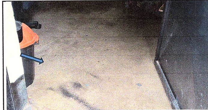
MODULO 03, foto 12: Sustitución de piso torta de cemento por piso ceramico
