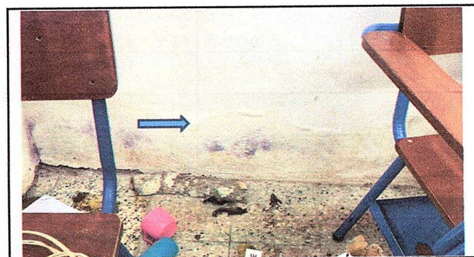
Modulo 2, foto 4: Reparacion y aplicación de impremiabilizante y antisalitre en muros
