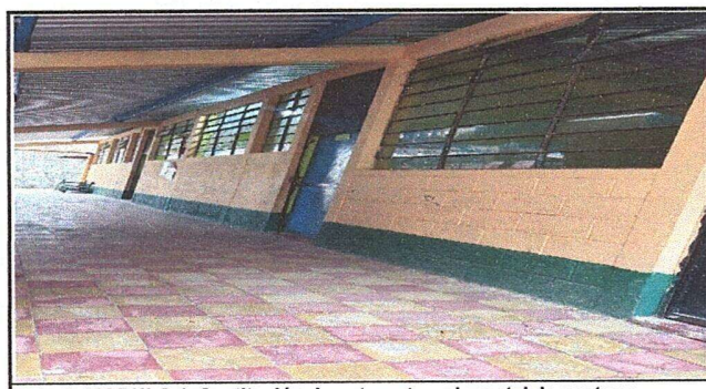
Foto 5: MODULO 1. Sustitución de estructura de metal de ventana-balcones y vidrios de 4mm transparente.
