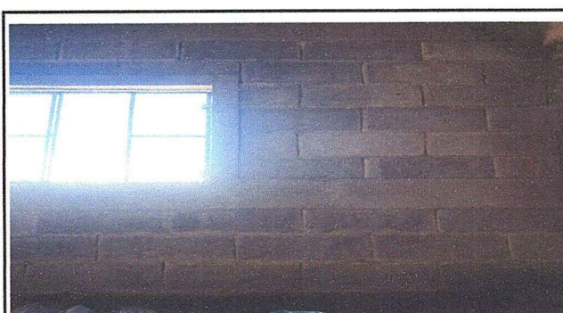
Foto 4: MODULO 2. Pintura en muros exteriores e interiores.
