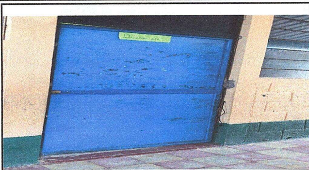
Foto1: MODULO 1. Sustitución de puertas de metal
