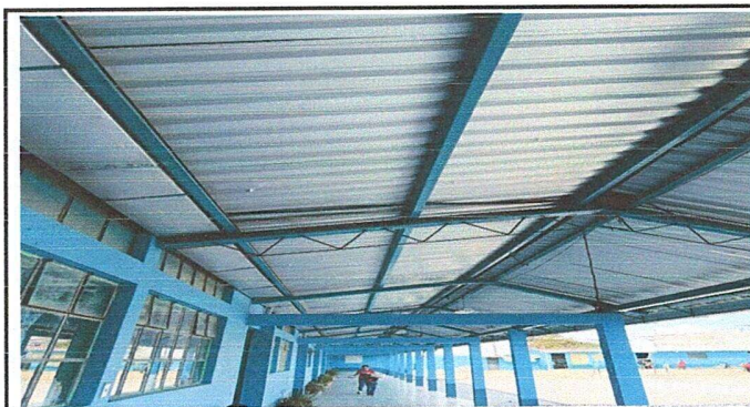
Foto 3: Módulo 1. Sustitución de estructura de soporte de metal, por metal.
