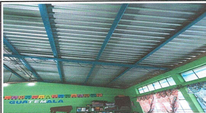
Foto 4: Módulo 1. Sustitución de estructura de soporte de metal, por metal.
