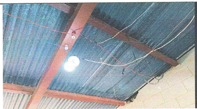
Foto 3: MODULO 1: Sustitución de plafonera y sustitución de focos led, reparación de cableado eléctrico y sustitución de ducto eléctrico.
