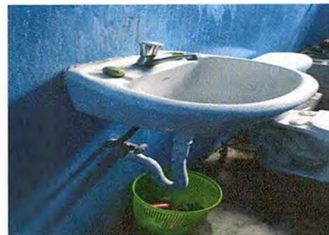
Foto 4: MODULO 1: SUSTITUCIÓN DE GRIFO
