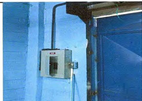
Foto 6: MODULO 1: SUMINISTRO DE TABLERO ELECTRICO Y FLIPONES 220
