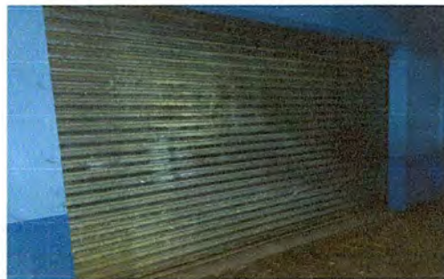
Foto 8: Modulo 2: SUMINISTRO E INSTALACIÓN DE PUERTA DE REJA EN INGRESO (3X2.30)
