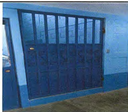
Foto 14: Modulo 6: SUSTITUCIÓN DE PUERTA DE METAL
