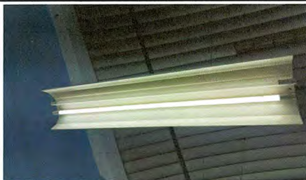
Foto 15: Modulo 7: REPARACIÓN DE LAMPARA LED DE 48"
