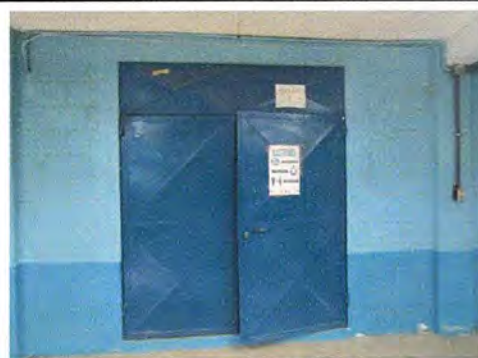
Foto 16: Modulo 7: SUMINISTRO E INSTALACIÓN DE PUERTA DE REJA EN INGRESO (1.1X2.30)
