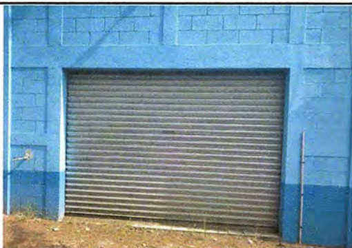
Foto 13: Modulo 5: SUMINISTRO E INSTALACIÓN DE PUERTA DE REJA EN INGRESO (3X2.30)
