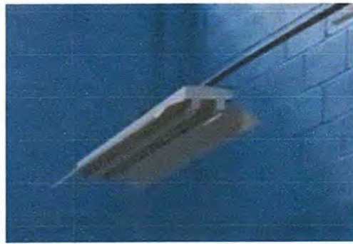
Foto 10: Modulo 4: REPARACIÓN DE LAMPARA LED DE 48"
