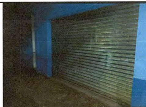
Foto 12: Modulo 4: SUMINISTRO E INSTALACIÓN DE PUERTA DE REJA EN INGRESO (3X2.30)
