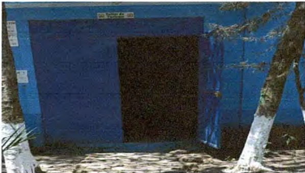
Foto 7: Modulo 2: SUMINISTRO E INSTALACIÓN DE PUERTA DE REJA EN INGRESO (2X2.30)
