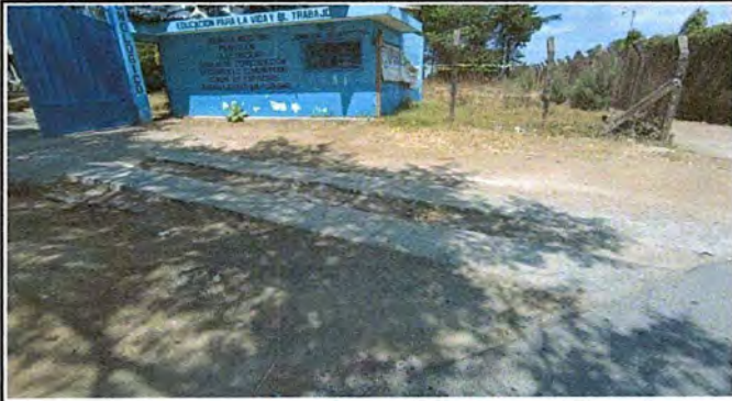
Foto 1: INGRESO : SUSTITUCIÓN DE TORTA DE CONCRETO POR TORTA DE CONCRETO (INCLUYE RETIRO DE CONCRETO EXISTENTE)
