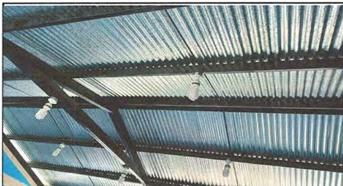
Foto 7: Reparación de sistema eléctrico, sustitución de lámpara
