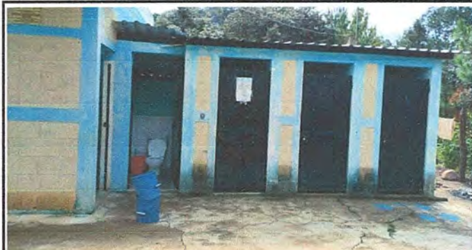
Foto 6: Mantenimiento a estructuras de puerta, fijado, cepillado, sujeciones, aplicación de pintura.
