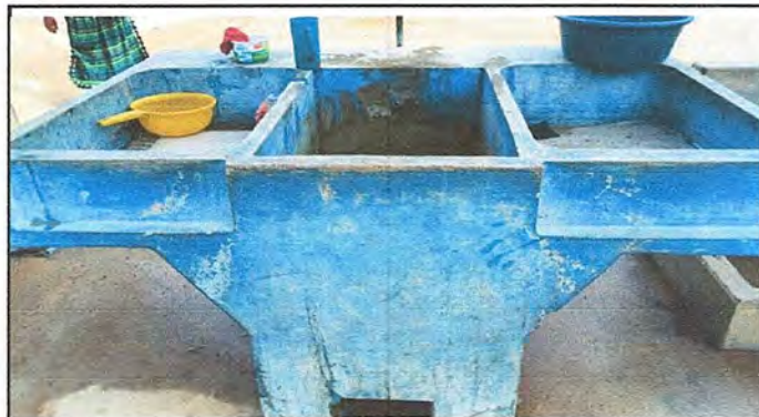
Foto 8: Sustitución de pila de dos lavaderos, instalación de pila.
