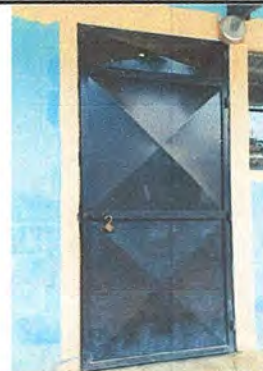
Foto 2: Sustitución de chapa, mantenimiento a estructuras de puerta (fijado, cepillados, sujeciones, aplicación de pinturas.)
