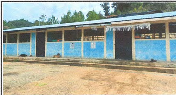
Foto 4: Sustitución de canal pvc, sustitución de soporte o pescante de metal para canal, sustitución de bajada de agua pluvial de metal por tubo pvc 3
