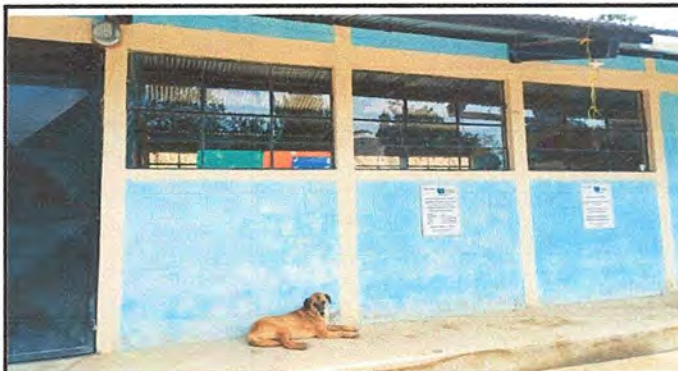
Foto 3: Fabricación e instalación de balcón de hierro en ventana.
