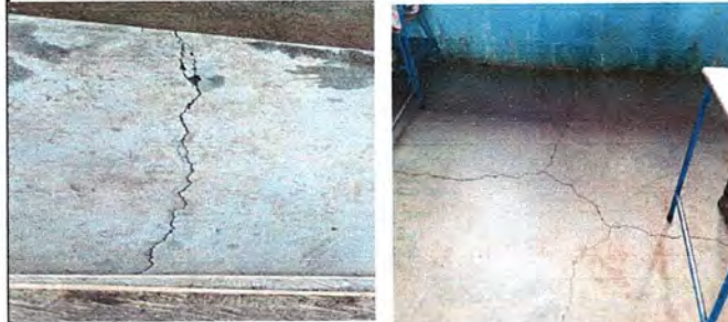
Foto 2: Sustitución de piso de torta a piso granito
