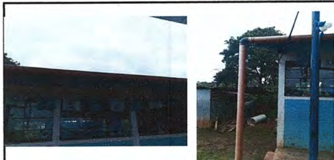
Foto 5: Sustitución de canal pvc
