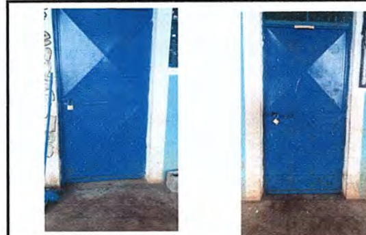
Foto 6: Mantenimiento de puertas (incluye corte de puerta)
