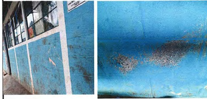
Foto 4: Pintura de paredes interiores y exteriores
